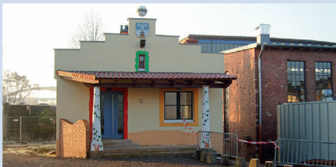
Villa Kunterbunt vor und nach dem Umbau
