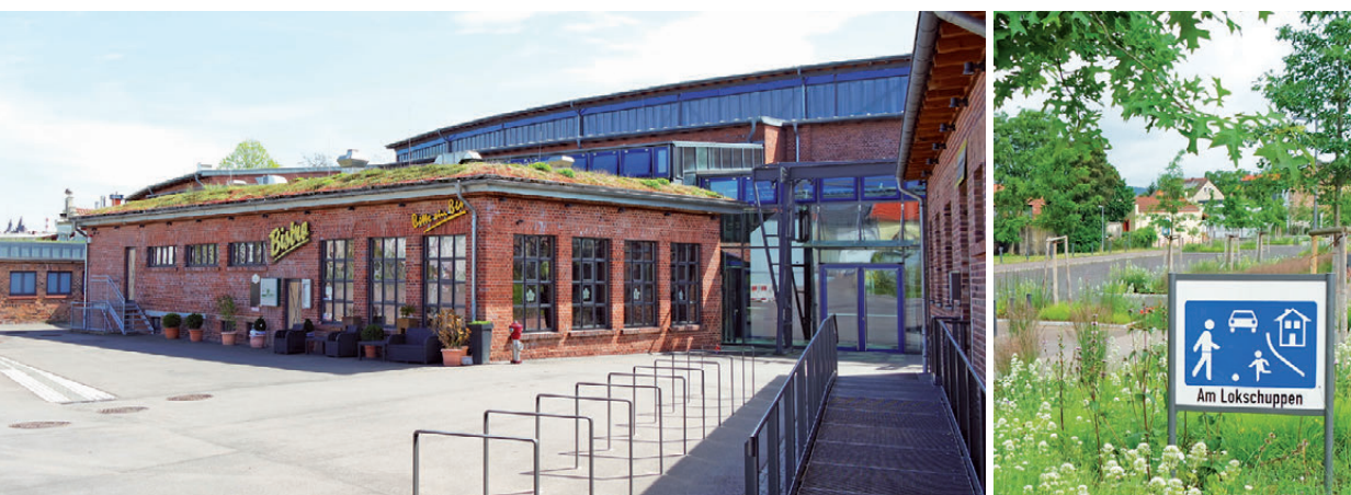
Lokschuppen in Dillingen
