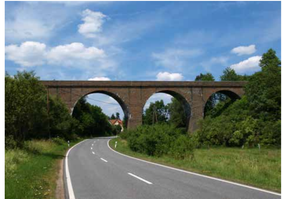
Eisenbahnviadukt bei Hauptertweiler, LDA 2015
