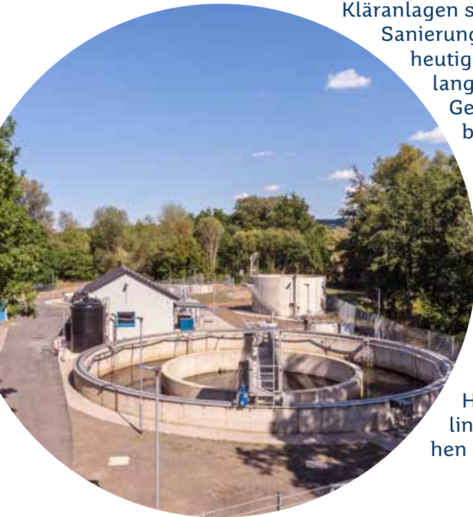
Abbildung 12: Kläranlage Erfweiler- Ehingen
