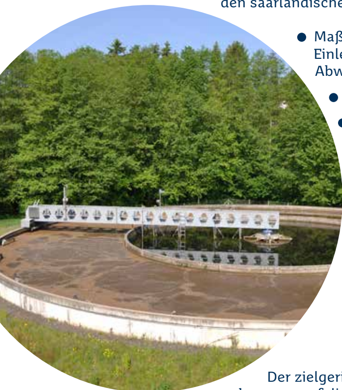
Abbildung 2 Kläranlage Bubach- Calmesweiler
