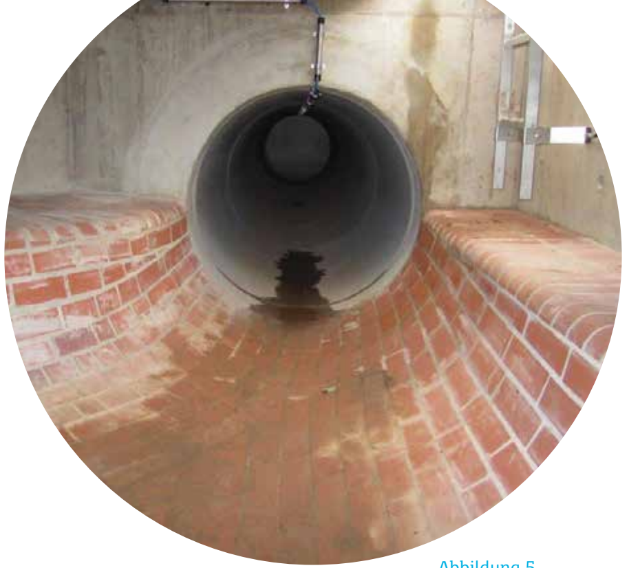
Abbildung 5 Regenüberlaufbecken in der Abwasseranlage Niedersaubach, Lebach
