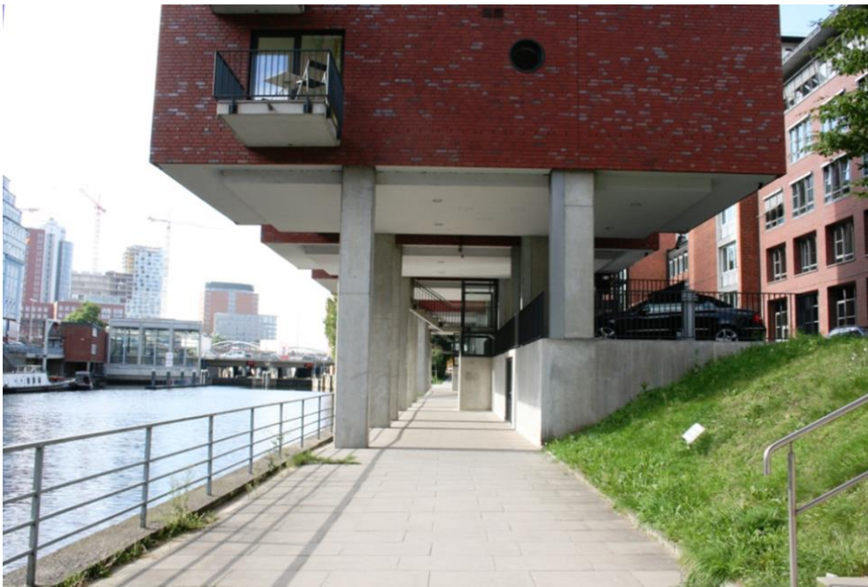
Abbildung 17: Aufgeständerte Gebäude in der Hafencity in Hamburg (Quelle: Gretzschel, 2010)
