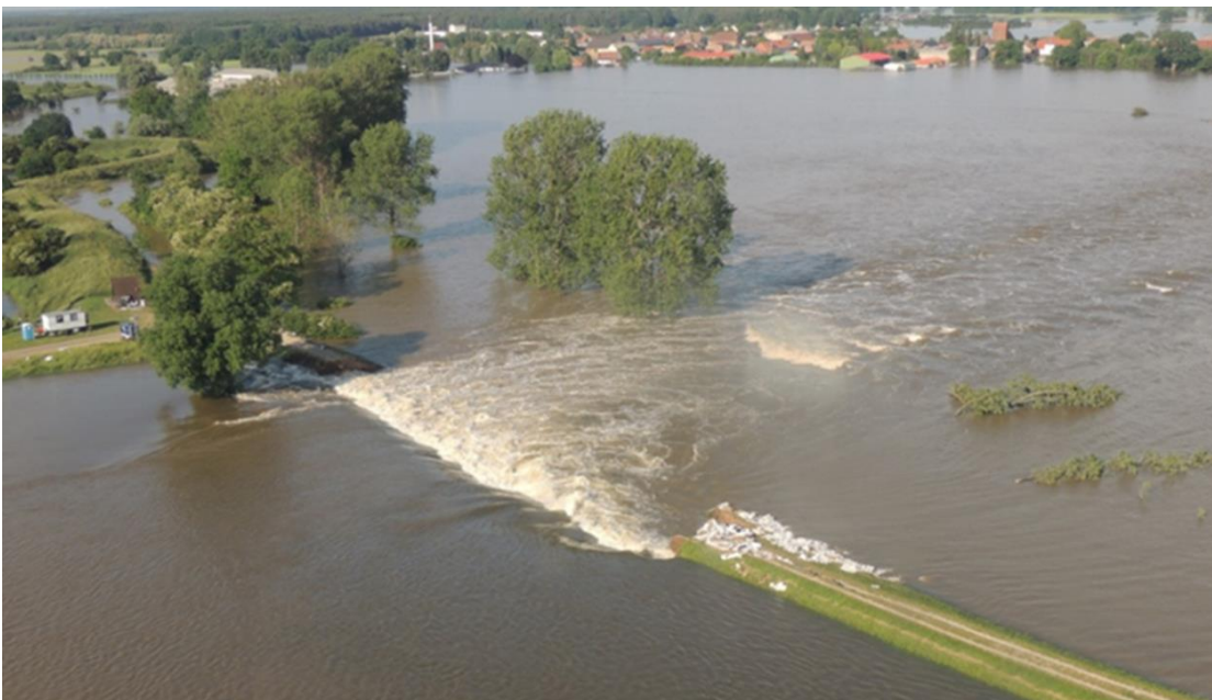
Abbildung 3: Deichbruch bei Fischbeck an der Elbe 2013 (Quelle: Jüpner, 2013)
