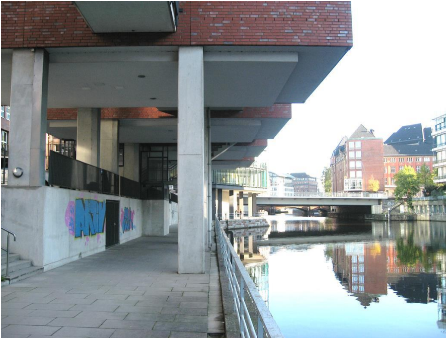
Abbildung 2: Hochwasserangepasste Bauweise in der Hafencity in Hamburg (Quelle: Hässler-Kiefhaber, 2011)
