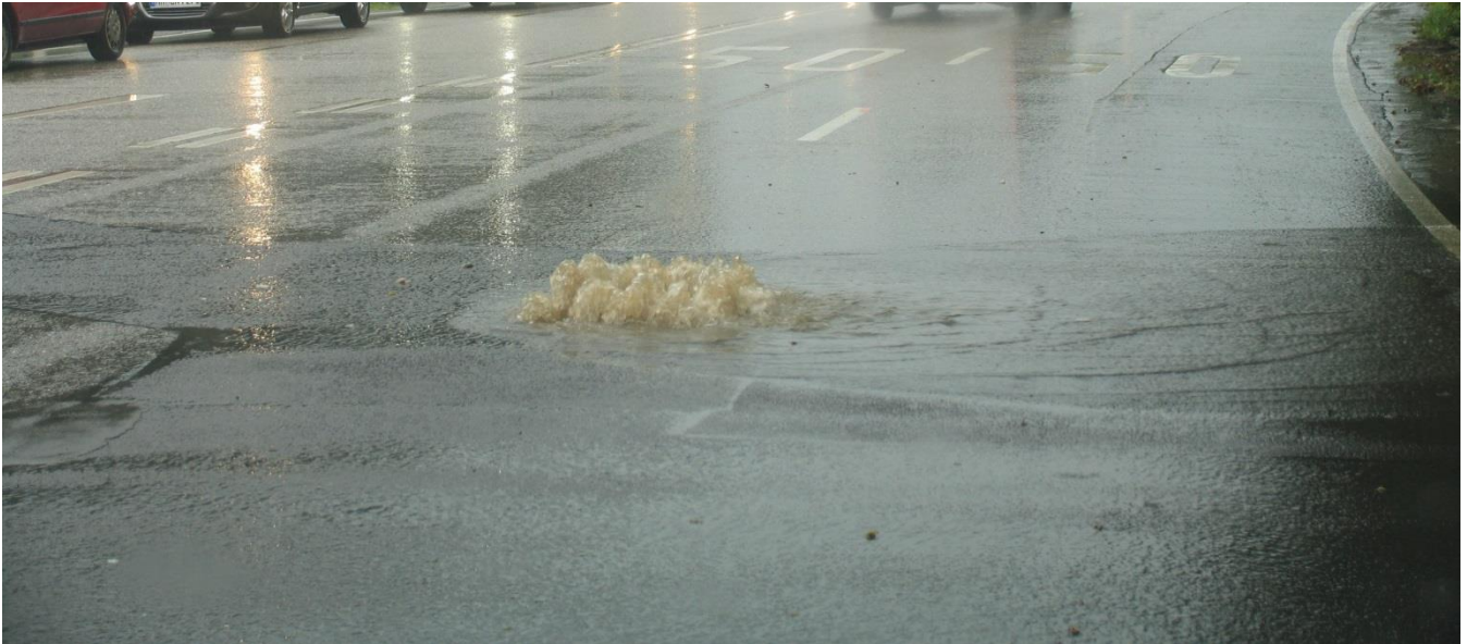
Abbildung 6: Kanalüberstau mit oberirdischem Abfluss auf der Straße (Quelle: OBERMEYER Planen + Beraten GmbH, Foto: Hässler-Kiefhaber)
