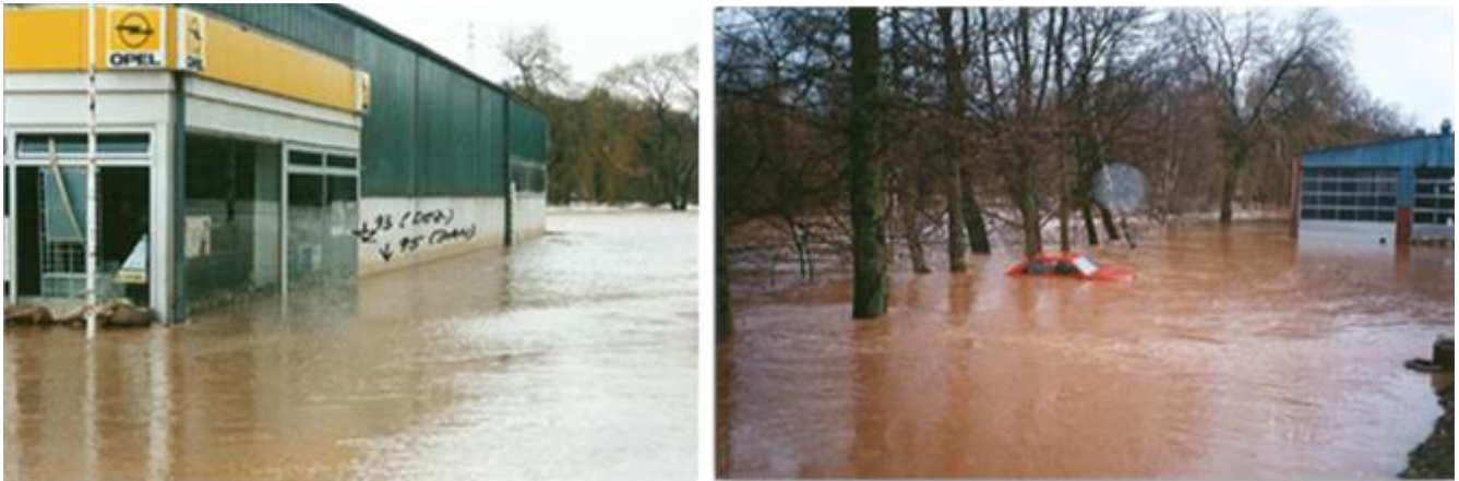
Abbildung 13: Nicht hochwasserangepasste Gebäude (Quelle: G. Seiler)
