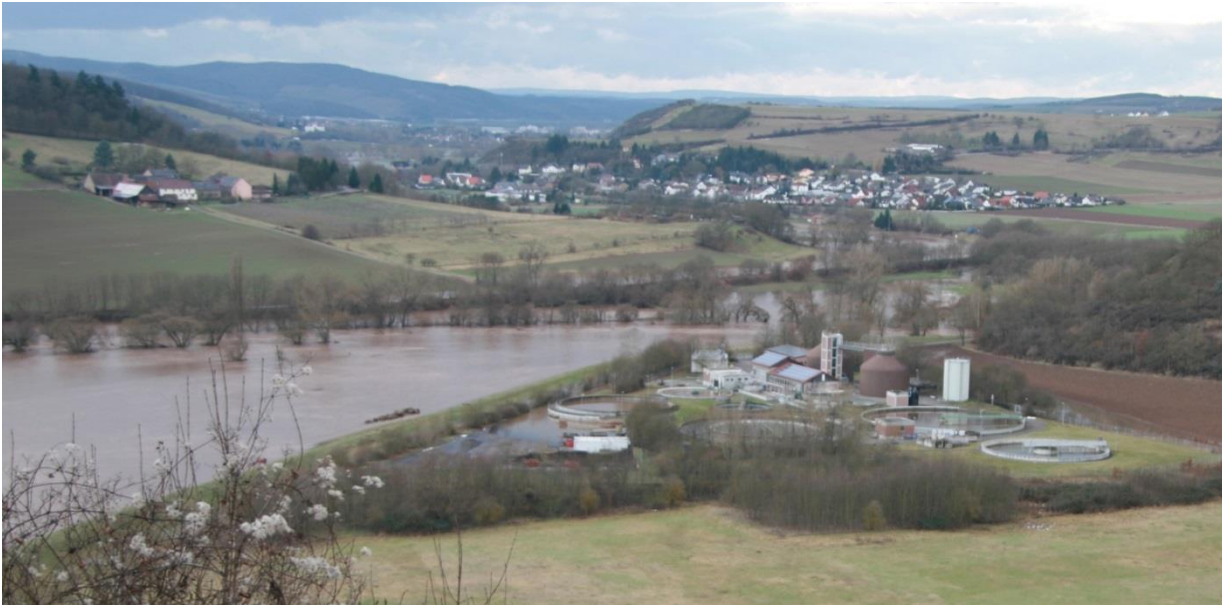
Abbildung 15: Kläranlage im ÜSG hinter einer Schutzeinrichtung (Quelle: OBERMEYER Planen + Beraten GmbH)
