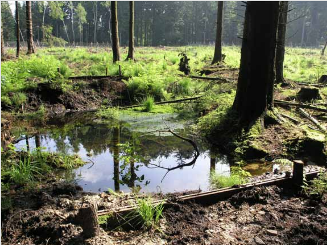
Um eine Wiedervernässung zu erreichen und das Wachstum der Torfmoose anzuregen, werden die Drainagegräben geschlossen
