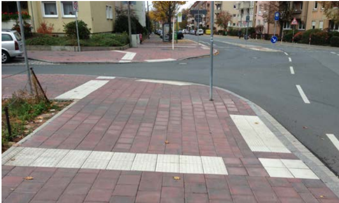
Bild 35: Getrennte Querungsstelle mit differenzierter Bordhöhe – Ausführungsbeispiel an einer ungesicherten Querungsstelle mit Lücke zwischen Auffindestreifen und Richtungsfeld [Foto: Boenke]
