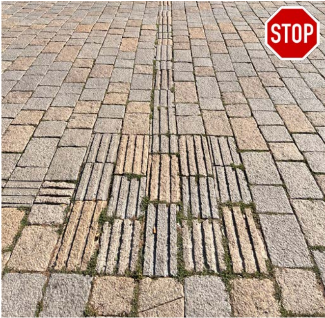
Bild 27: Beispiel für einen schlechten taktilen und visuellen Kontrast zwischen Bodenindikatoren und umgebendem Belag [Foto: Boenke]
