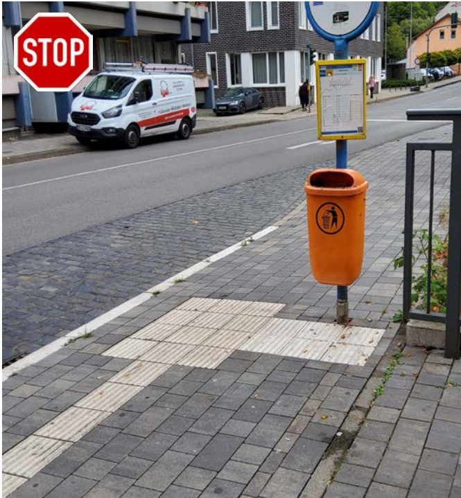
Bild 20: Ungünstige Position des Haltestellenmastes, kein ausreichender Abstand zum Auffindestreifen, Abfallbehälter ungünstig platziert [Foto: MUKMAV]
