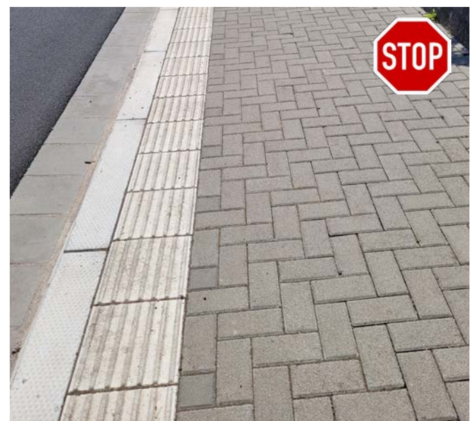
Bild 26: Leitstreifen mit zu geringem Abstand zur Bordkante, kein Begleitstreifen [Foto: MUKMAV]
