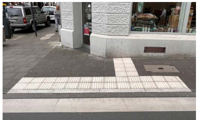
Bild 34: Gemeinsame Querungsstelle mit einheitlicher Bordhöhe – Ausführungsbeispiel an einer gesicherten Querungsstelle [Foto: Boenke]
