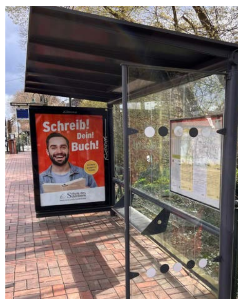
Bild 31: Markierungstreifen im Wechselkontrast erhöhen die Sichtbarkeit bei unterschiedlichen Lichtverhältnissen [Foto: Boenke]
