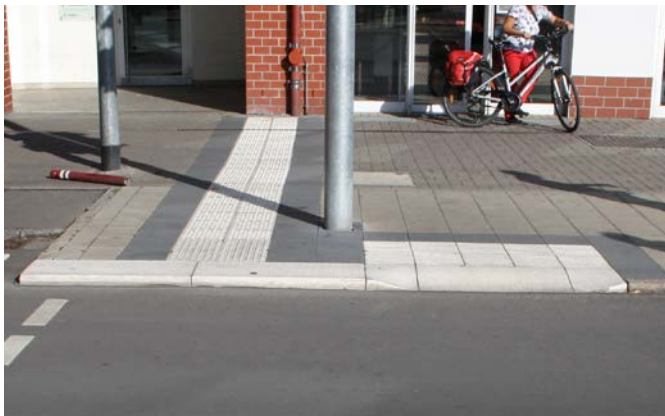
Bild 33: Getrennte Querungsstelle mit differenzierter Bordhöhe – Ausführungsbeispiel an einer gesicherten Querungsstelle [Foto: STUVA]
