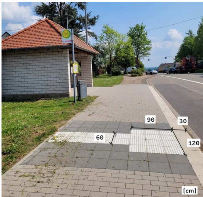
Bild 23: Begleitfläche neben Auffindestreifen und Einstiegsfeld, um taktilen und visuellen Kontrast sicherzustellen, Leitstreifen fehlt [Foto: MUKMAV]
