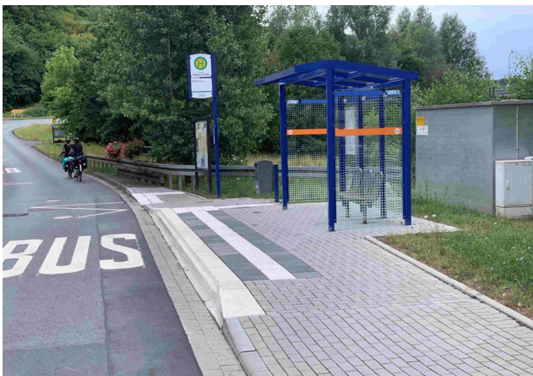
Bild 28: Beispiel für eine Haltestelle mit Auffindestreifen, Einstiegsfeld und Leitstreifen sowie hoher Haltekante (h = 22 cm) mit Kasseler Sonderbord plus [Foto: Boenke]
