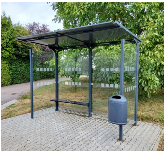
Bild 30: Fahrgastunterstand mit Glasflächenmarkierung in einer Höhe [Foto: MUKMAV]
