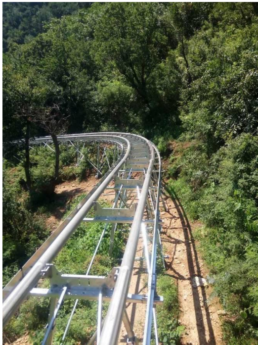
Foto 1: Beispielfoto der Konstruktion einer aufgeständerten Standseilbahn
