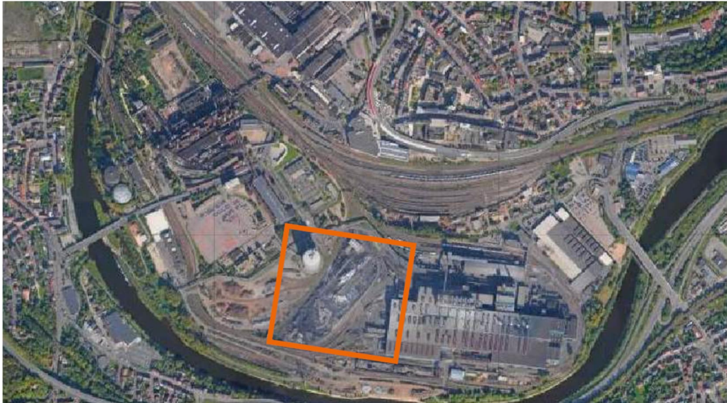
Figure : vue aérienne de l'emplacement prévu pour les installations
