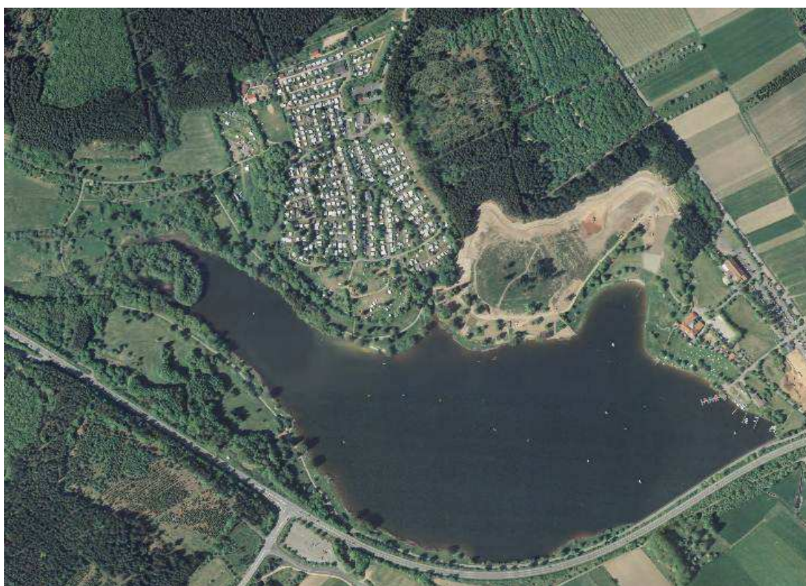
Abbildung 4: Stausee Losheim der Gemeinde Losheim am See (Quelle Bild: Gemeinde Losheim am See )
