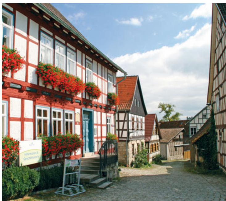
Fachwerkhäuser in Ummerstadt
