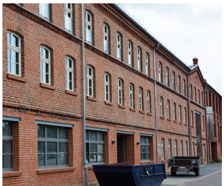
Der fertig gestellte Bildungsteil der Tuchfabrik
