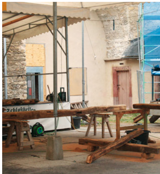
Bauarbeiten in Harzgerode
