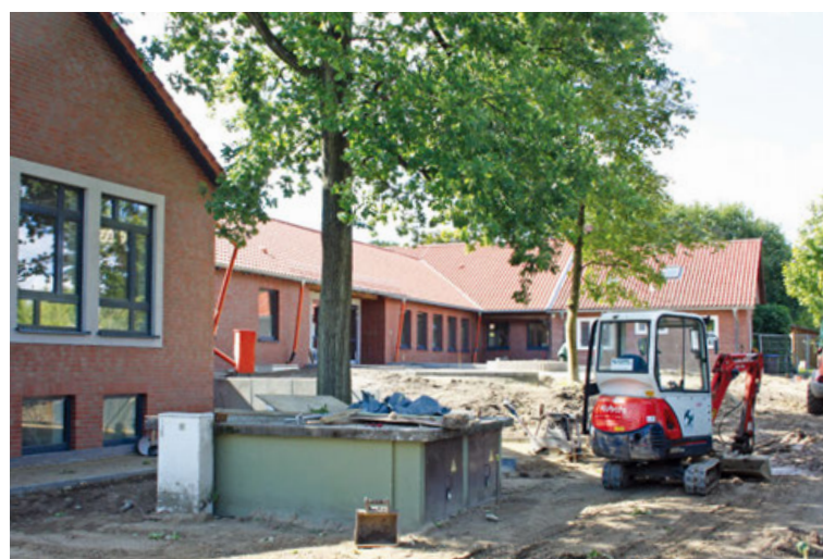
Baumaßnahmen an der Schule
