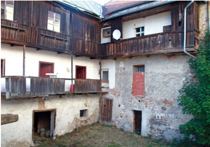
Der Innenhof der Bauhütte vor Beginn der Sanierung
