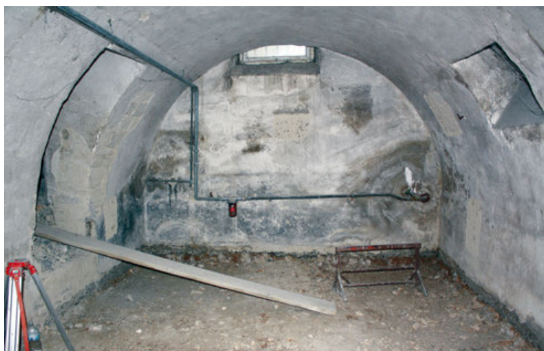
Das Kellergewölbe vor dem Umbau
