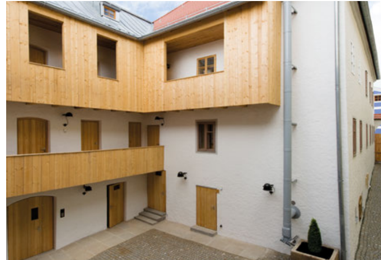
Denkmalgerechte Sanierung des Innenhofs
