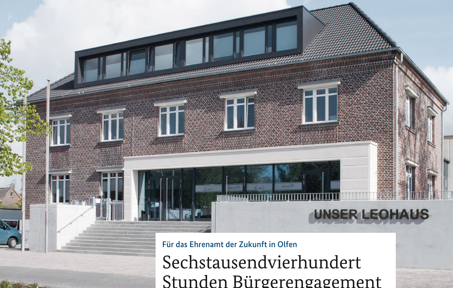
Das Leohaus nach der Fertigstellung
