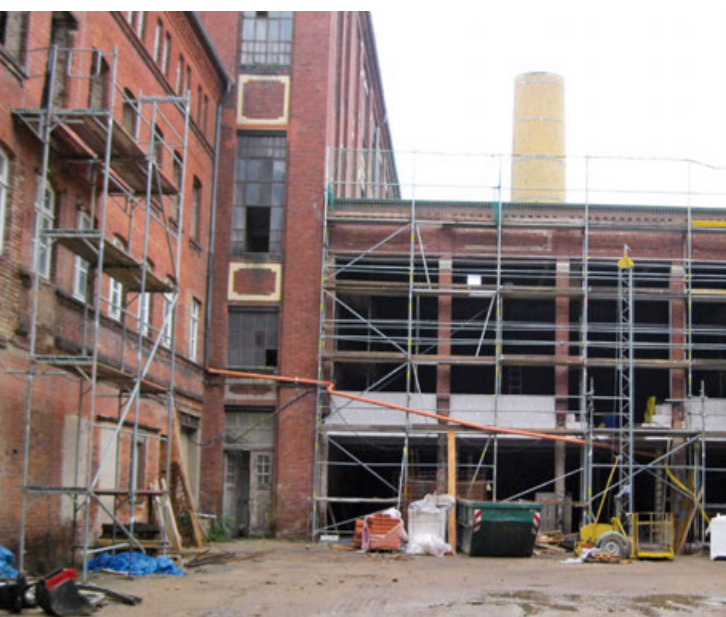
Die Baustelle der Tuchfabrik im Juli 2015
