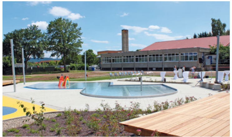
Neuer Freibadbereich vor dem (noch) unsaniertem Hallenbad
