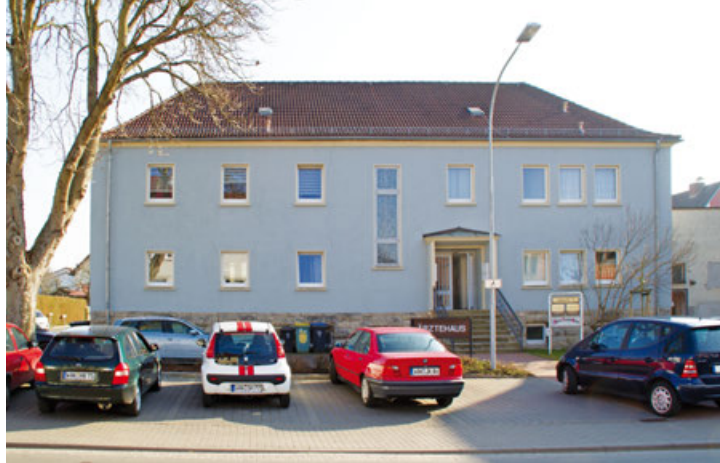
Das Ärztehaus vor der Sanierung
