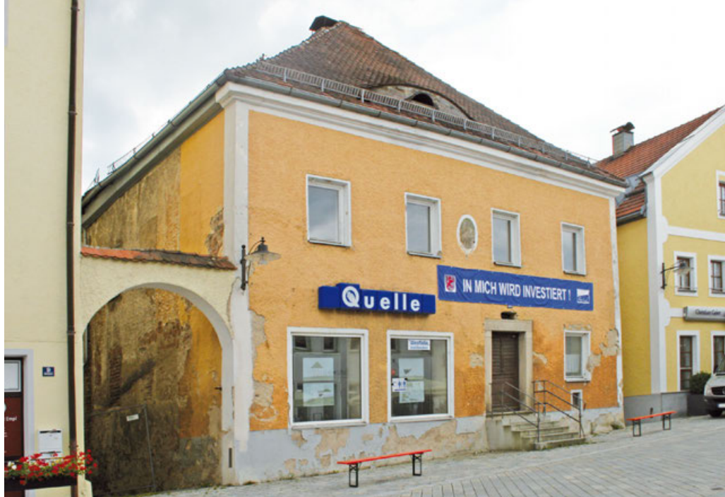
Die Bauhütte vor der Sanierung
