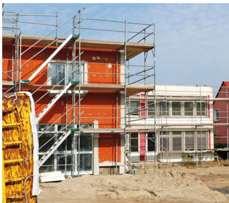
Umbau und Erweiterung einer Kita in Neuhausen
