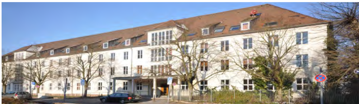
Abb.: Vorderseite des Hauptgebäudes Don-Bosco-Str. 1
