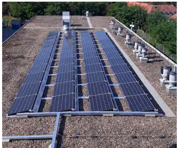
(PV-Anlage auf Garagendach am Standort Don-Bosco-Str.; Foto: LUA)
