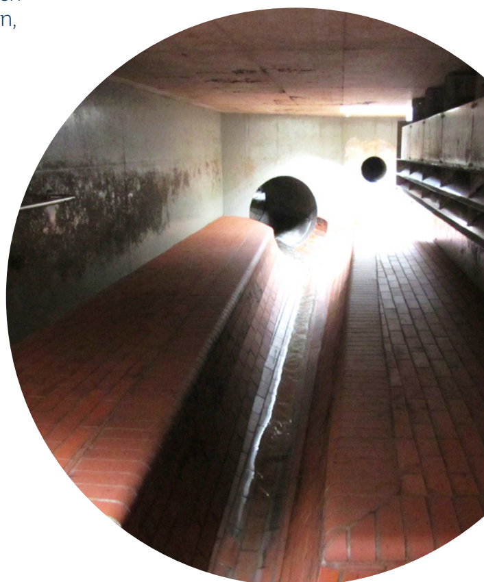
Abbildung 5: Regenüberlaufbecken in der Abwasseranlage 122
