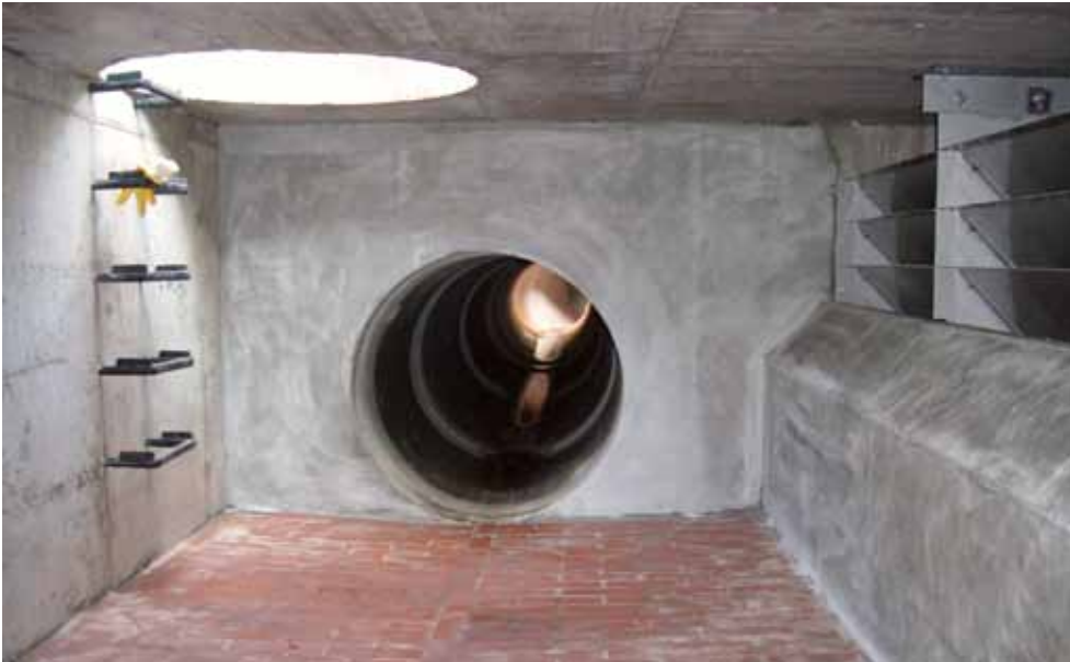
Abbildung 2: Regenüberlaufbecken in der Abwasseranlage 121
