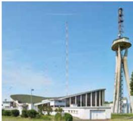
Die 1954/55 erbaute Sendehalle Europe 1 verband seinerzeit modernste Radiotechnik und avantgardistische Architektur. Die Sendehalle ist weltweit das erste Gebäude dieser Größenordnung mit einem aus Beton gegossenen, auf vorgespannten Seilen hängenden Dach. Bis zur Einstellung des Sendebetriebs zum 31.12.2019 galt der Sender als stärkster Langwellen-Sender Europas und als eine der größten Rundfunk-Sendeanlagen der Welt.
