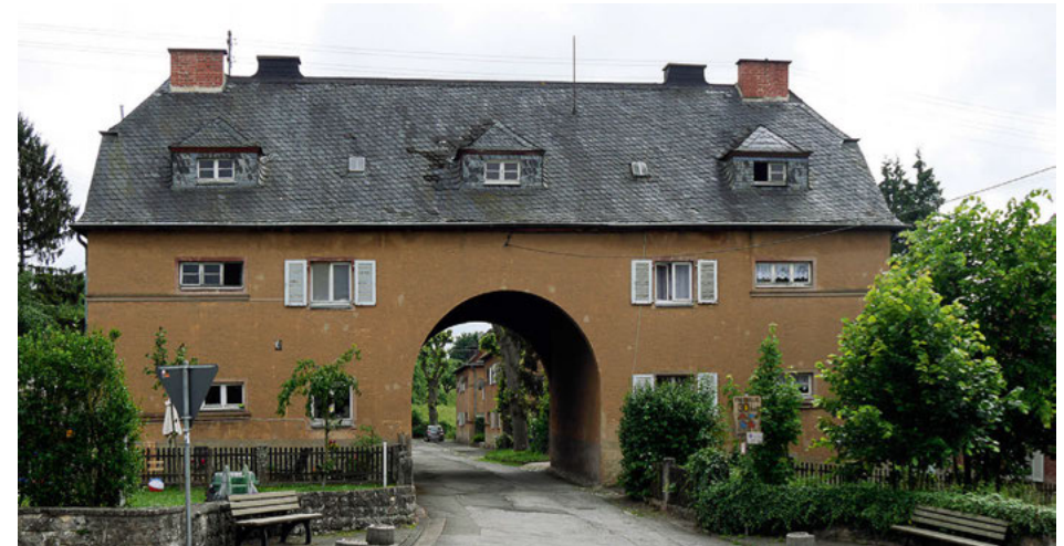
Wohn- und Torgebäude der Eisenbahnersiedlung, 2018
