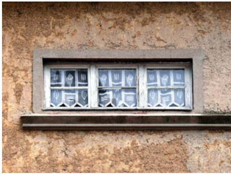
Bauzeitliches Fenster, Bahnhofstraße 63, 2018
