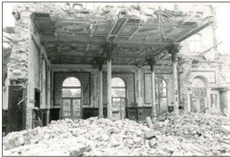
Abb. 7 Der Speiseraum im Abbruch, MDG Jean-Marie Schillings
