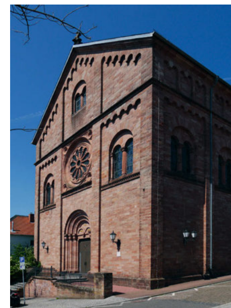
Haupt- und Langhausfassade, 2017
