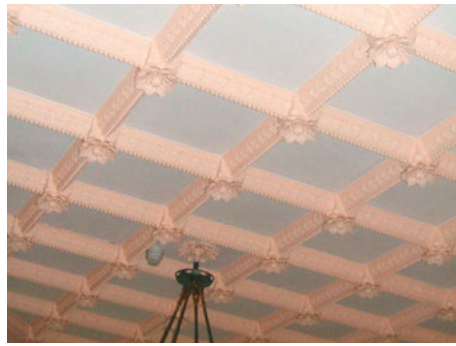
Abb. 7 Decke des Verteilerraumes der ersten Etage, Detail, Denkmalkataster für Ostbelgien, Michaela Schumacher
