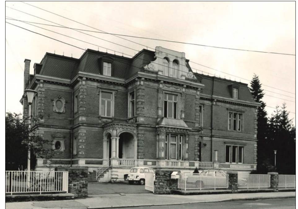
Abb. 1 Außenansicht, © KIKIRPA Brüssel
