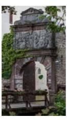
wieder eingebaut, sondern durch neu angefertigte Zwillings-Gewände in Renaissance Form ersetzt. Als Dacheindeckung erhielten alle Dächer eine Eindeckung aus Naturschiefer. Teile der Anlage blieben steinsichtig mit verbandelten Fugen. Das Renaissance Gebäude und die drei Rundtürme wurden verputzt und gekalkt. Erschlossen wird die Burg über eine neu angelegte Brücke welche den rekonstruierten Burggraben überspannt.
