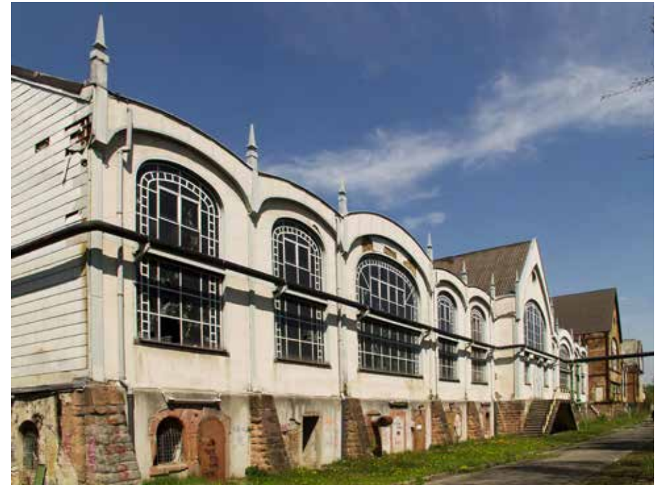
Halle außen Detail, 2009
