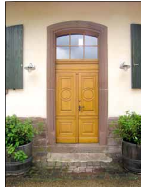
nach Befund erneuerte Haustür, 2012
