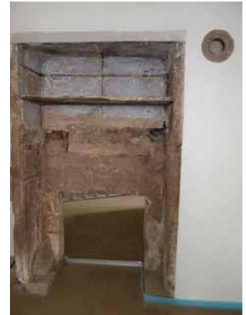
Birkenstraße 1, aufgedeckte Takenanlage vor der Restaurierung
