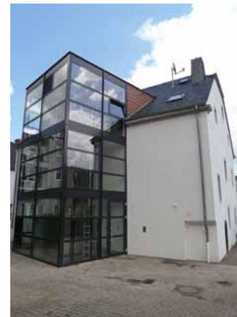
Rückseite mit gläsernem Anbau
