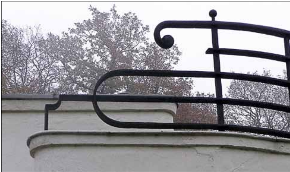
Geländer, Balkon Detail / garde-corps, balcon détail © Irmgard Mailandt, Aachen
