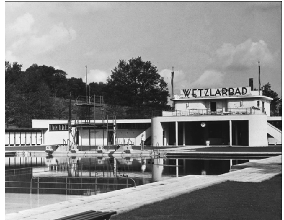
Gesamtansicht mit Becken / vue générale avec bassin © Rheinisches Bildarchiv Köln
