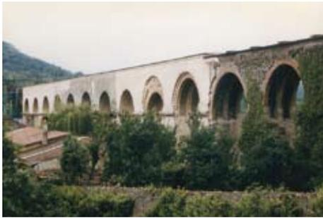
*Das Aquädukt von Jouy et Ars bei Metz hat eine besondere Eigenheit, das von dem Teil, der sich in der Luft befindet, herrührt. Es sind die beiden riesigen Becken, die an jedes Ende einer gewaltigen Brücke gebaut wurden und die das Moseltal überqueren. Das Bauwerk erstaunt durch seine Länge sowie seine Breite, die durch zwei parallel laufende Leitungen ermöglicht werden können. Dieses Charakteristikum stellte eine Einmaligkeit für die römische Zeit dar.*
