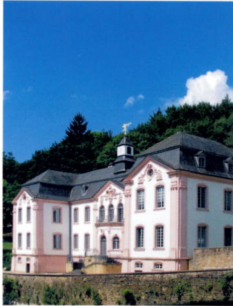
Schlossfassade von Osten
