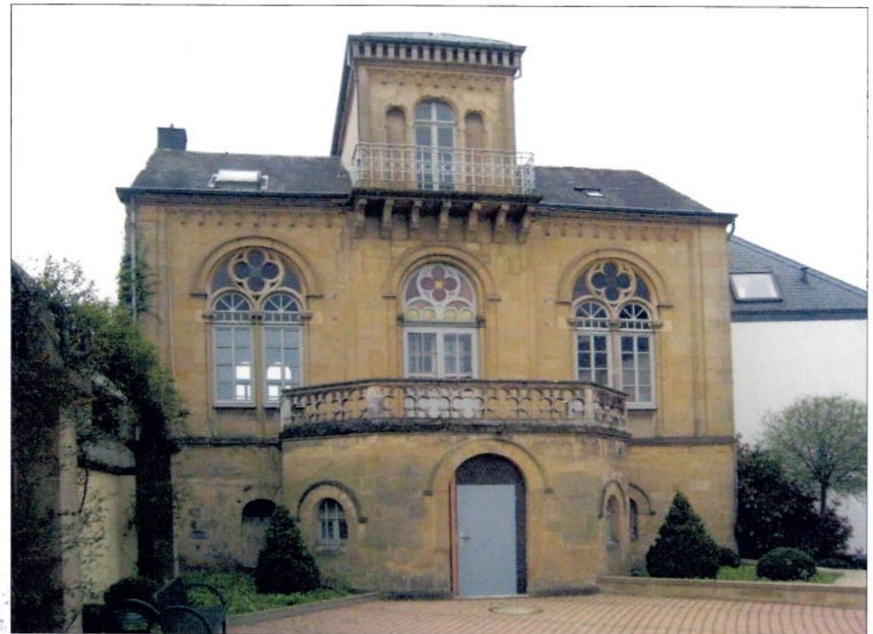
Maison Dufaing, Façade principale
