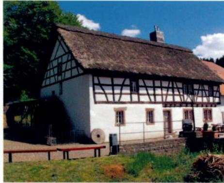
Jahresringe mit einem bestimmten Zeitraum der süddeutschen Eichenchronologie) in wesentlichen Bereichen in das Jahr 1739 datiert werden. Das längsrechteckige zweiraumtiefe Gebäude besteht aus dem massiv gemauerten und verputzten Erdgeschoss und dem weitgehend in Fachwerk aufgeführten Obergeschoss. Ein ausgedehnter Speicherraum erstreckt sich unter dem hohen Satteldach, das wie alle übrigen Bauten bis in die 1930er Jahre noch mit Langstroh gedeckt war.
