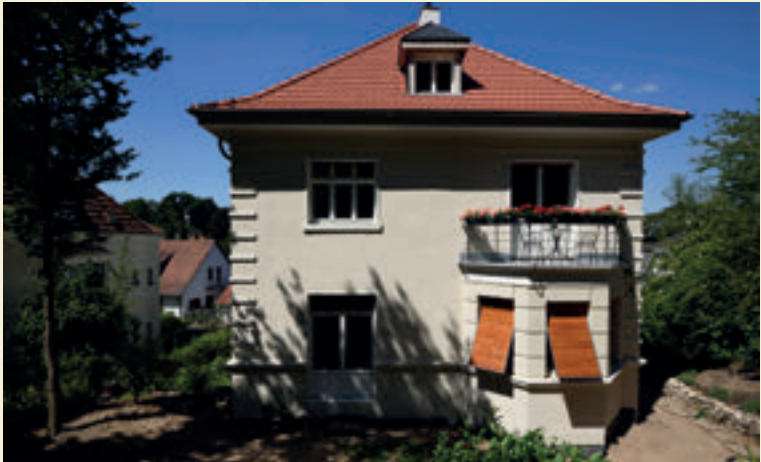
Saarbrücken, Reppersbergstraße 40, Straßenansicht, Foto: Architekt Kalkoffen, 2020
