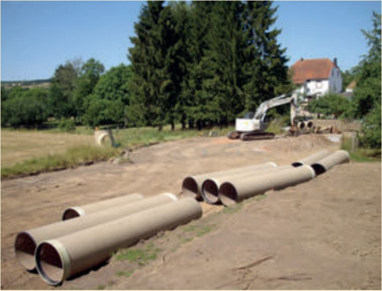
Habkirchen, Saarpfalz-Kreis: Die Fläche wird für den Bau des Hauptwassersammlers vorbereitet. Es ist nicht immer nur ein schmaler Graben, in den die Rohre verlegt werden. Meistens ist ein größeres Gebiet von Bodeneingriffen betroffen, als die eigentliche Maßnahme vermuten lässt, Foto: 2019
