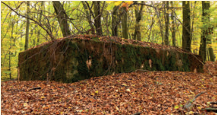
Bunker WH-Nr. 64, Foto: 2018
