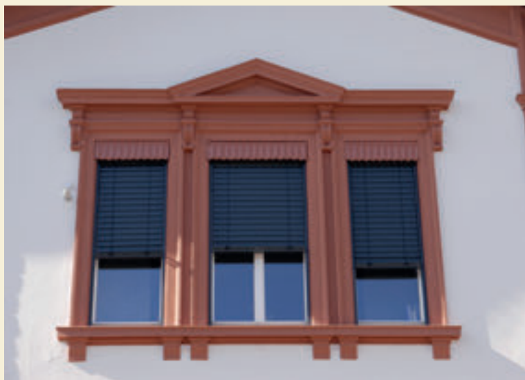
Kaiserstraße 3, Fenster des 1. Obergeschosses im Mittelrisalit mit Außenschabracken, Foto: 2020
