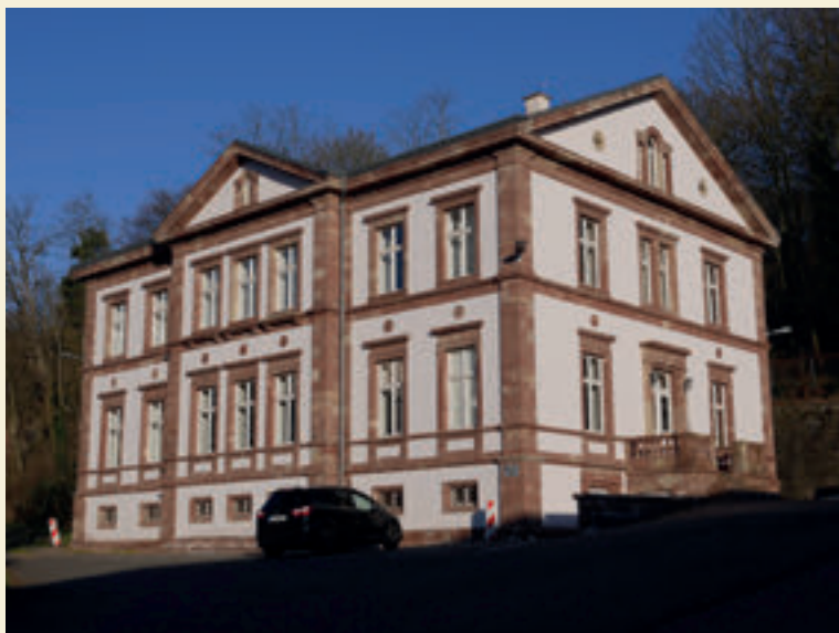
Süd- und Ostfassade, Foto: 2020
