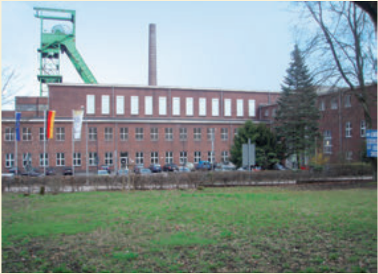
Das Landesdenkmalamt im instand gesetzten Zechengebäude des ehemaligen Bergwerks Landsweiler-Reden. Foto: 2008
