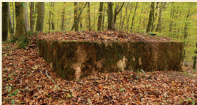
Bunker WH-Nr. 66, Foto: 2018
