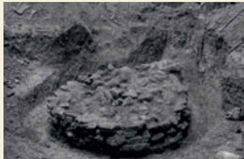
4 Der 1927 freigelegte römische Töpferofen, Foto: LDA / C. Klein
