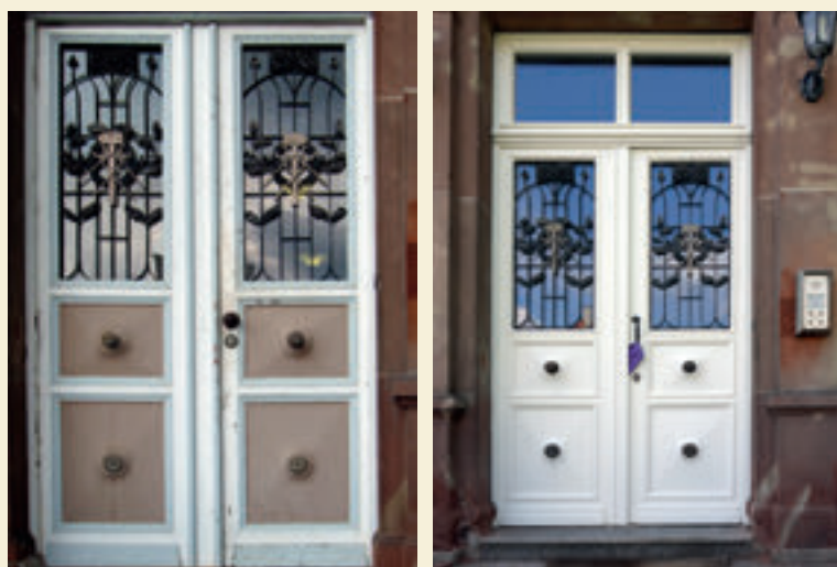
Frühere Eingangstür und erneuerte Eingangstür, Fotos: 2007 und 2018
