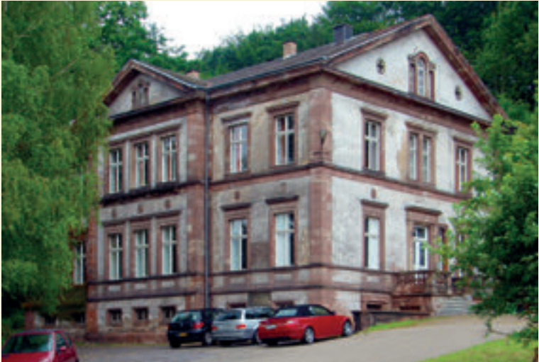
St. Ingbert, Alleestraße 11, Hauptverwaltung, Süd- und Ostfassade, Foto: 2007
