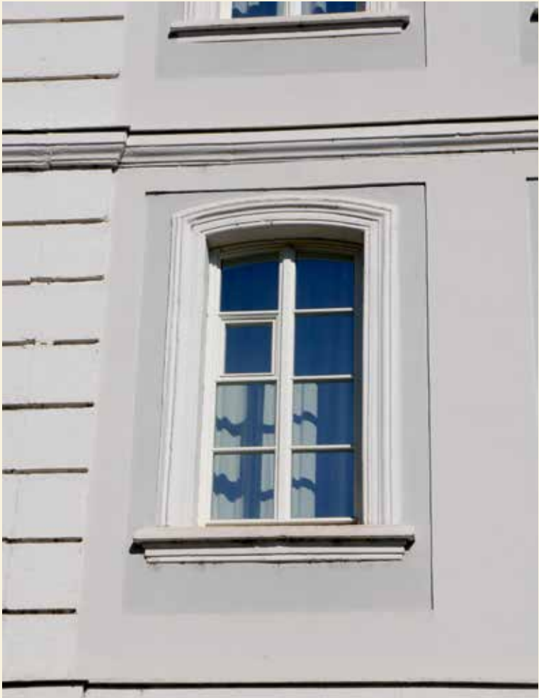
1 Saarbrücken, Altes Rathaus, erneuertes Fenster, Foto: 2017
