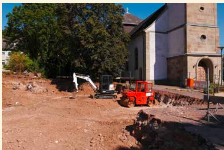
1 Baugrube neben der katholischen Pfarrkirche von Nalbach, links die Ausgrabung. Der Bau stammt aus dem 18. und 19. Jh., hat aber mittelalterliche Vorgänger. So dicht neben alten Kirchen ist in der Regel mit Grabfunden zu rechnen. Die Friedhöfe wurden häufig in der zweiten Hälfte des 19. Jhs. von den Kirchen weg an die Ortsränder verlegt und sind heute oberirdisch nicht mehr erkennbar, Foto: 2016
