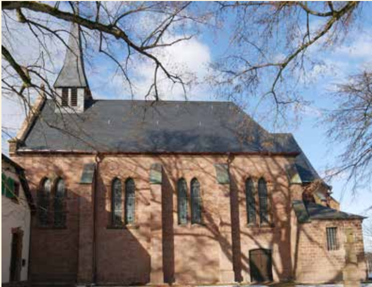
1 Illingen, Bergkapelle, Südansicht nach Instandsetzung, Foto: 2016
