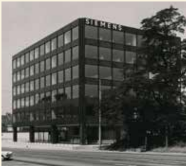
2 Siemensgebäude, Straßenfassade 1964, Foto: Archiv Peter C. v. Seidlein
