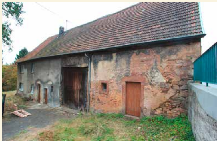
2 Wiebelskirchen, Im Stauch 18, Ansicht Fassade, Foto: 2016
