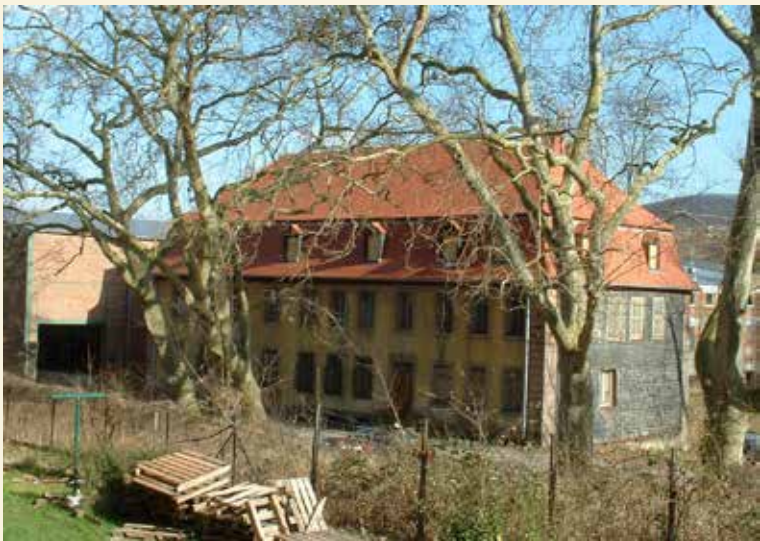
1 St. Ingbert, Herrenhaus der Alten Schmelz, Blick von Nordwesten, Foto: 2006
