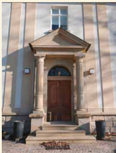
2 Völklingen, Villa Stutz, Eingangsportal nach Instandsetzung, Foto: 2016
