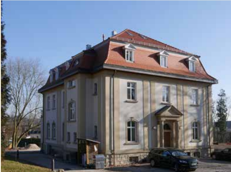
1 Völklingen, Villa Stutz, Ansicht nach Instandsetzung, Foto: 2016
