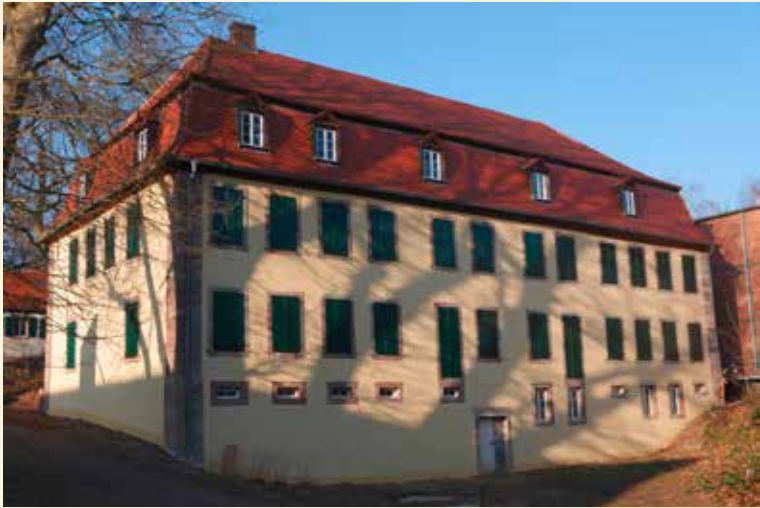
3 Süd- und Westseite des Herrenhauses, Foto: 2017
