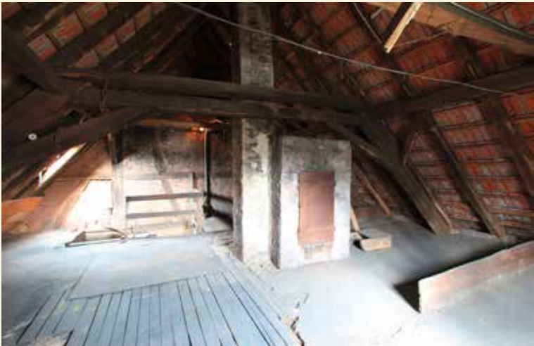
3 Wiebelskirchen, Im Stauch 18, Dachstuhl, Foto: 2016
