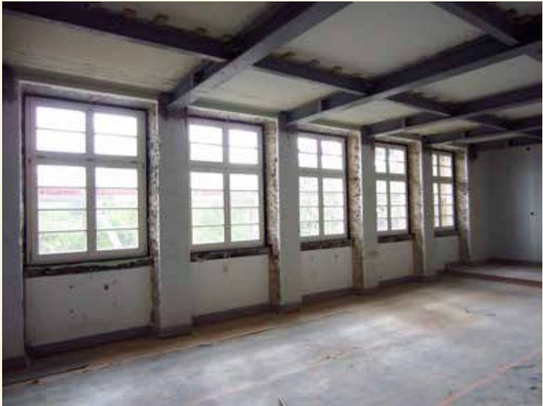
3 Ehemalige Pausenhalle im 2. Obergeschoss mit eingebauter statischer Ertüchtigung, Foto: 2015
