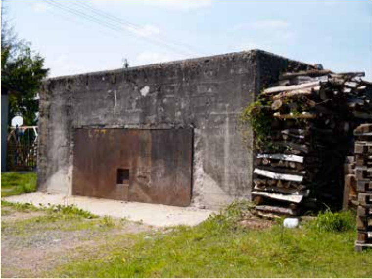
2 Nohfelden Eisen, Bunker WH-Nr. B13b, Foto: 2005
