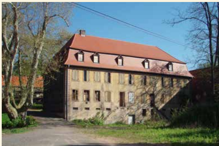
2 Herrenhaus der Alten Schmelz, Blick von Süden auf die Rückfront nach der Neueindeckung und vor dem Abbruch der Vortreppe, Foto: 2008
