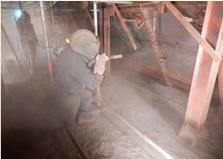
3 Zustand Innenraum vor Sanierung, Foto: Kluge/Lobbe AG 2014
