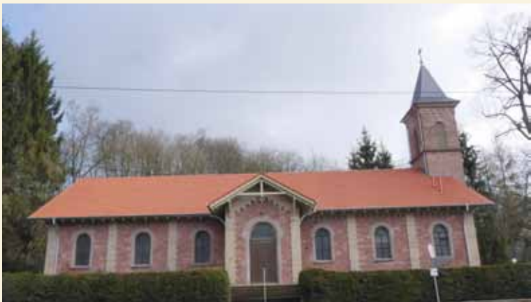
2 Schiffweiler-Heiligenwald, Karlstraße1, Ansicht nach Instandsetzung, Foto: 2015
