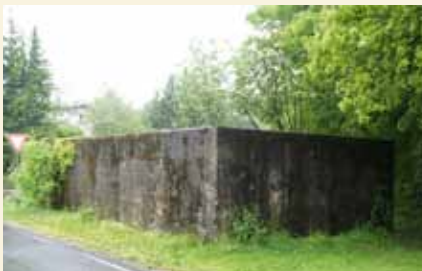
14 Landkreis St. Wendel, Gemeinde St. Wendel, Gemarkung Hoof, Neue Straße, Flurstück 12, Mannschaftsunterstand WH-Nr. 320, Luftverteidigungszone West, 1939 (Einzeldenkmal)
