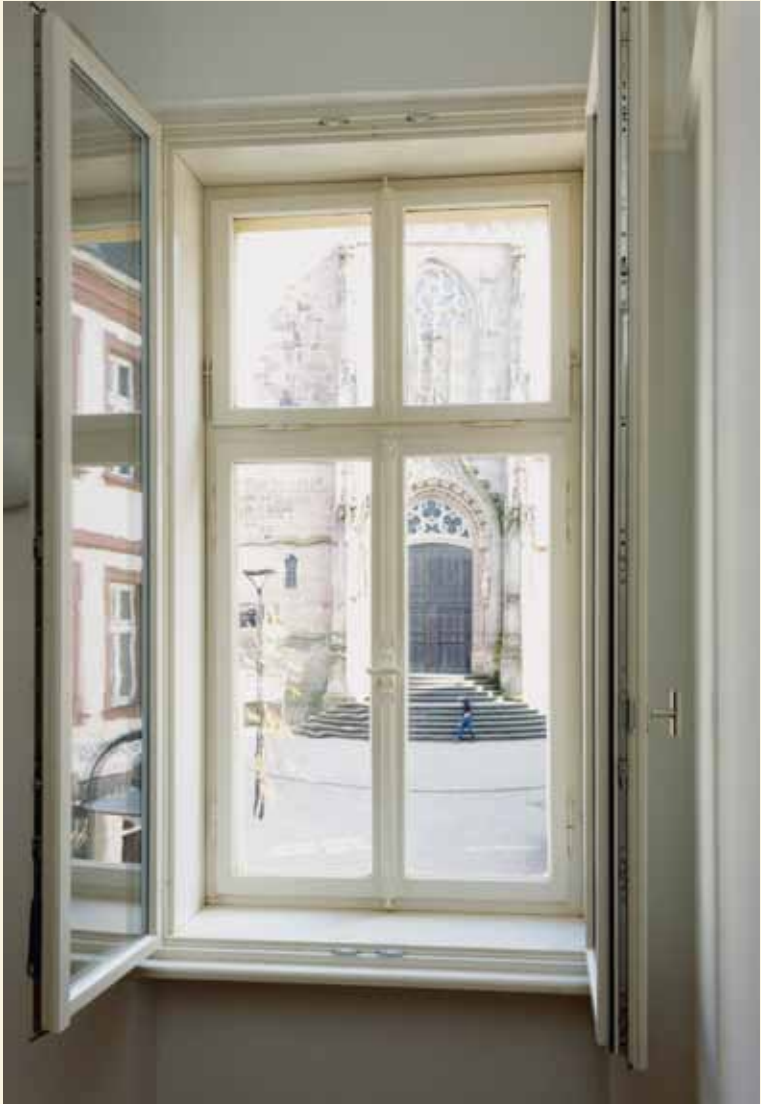
St. Wendel, Neues Rathaus/Haus Colbus, saniertes Fenster, Foto: 2015
