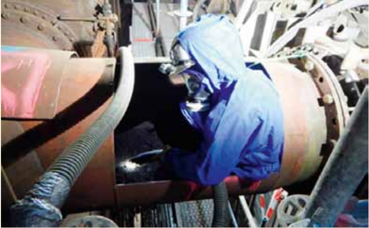
4 Rohrsanierung, Foto: Andreas Timm 2015
