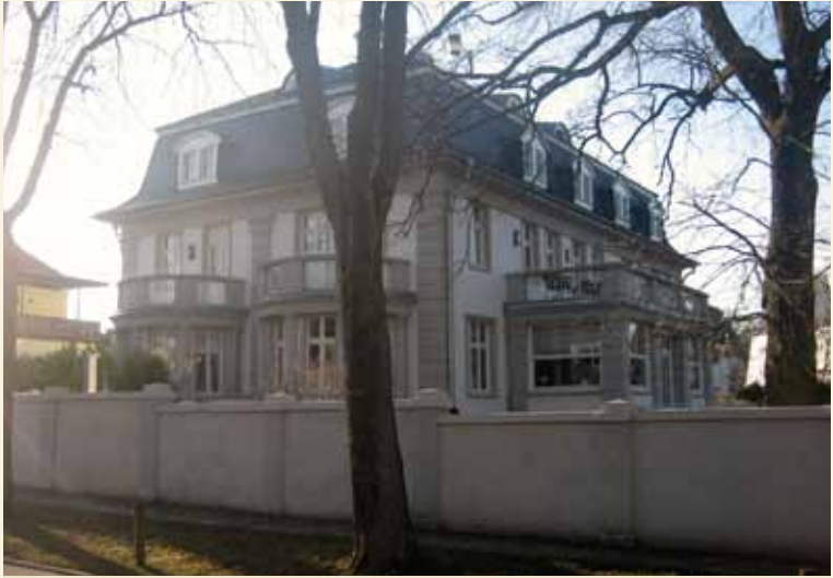
2 Straßenansicht nach Fertigstellung Foto: 2016
