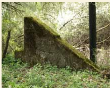
11 Landkreis St. Wendel, Gemeinde Nohfelden, Gemarkung Walhausen, Rechts vom Birkenfelderweg (Gewann), Flur 2, Flurstücke 13, 41, Straßendurchfahrtsperre, Luftverteidigungszone West, 1939 (Einzeldenkmal)
