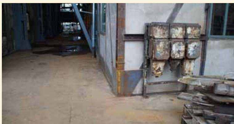
7 Stahlbau TGR I während der Arbeiten, Foto: Andreas Timm 2015
