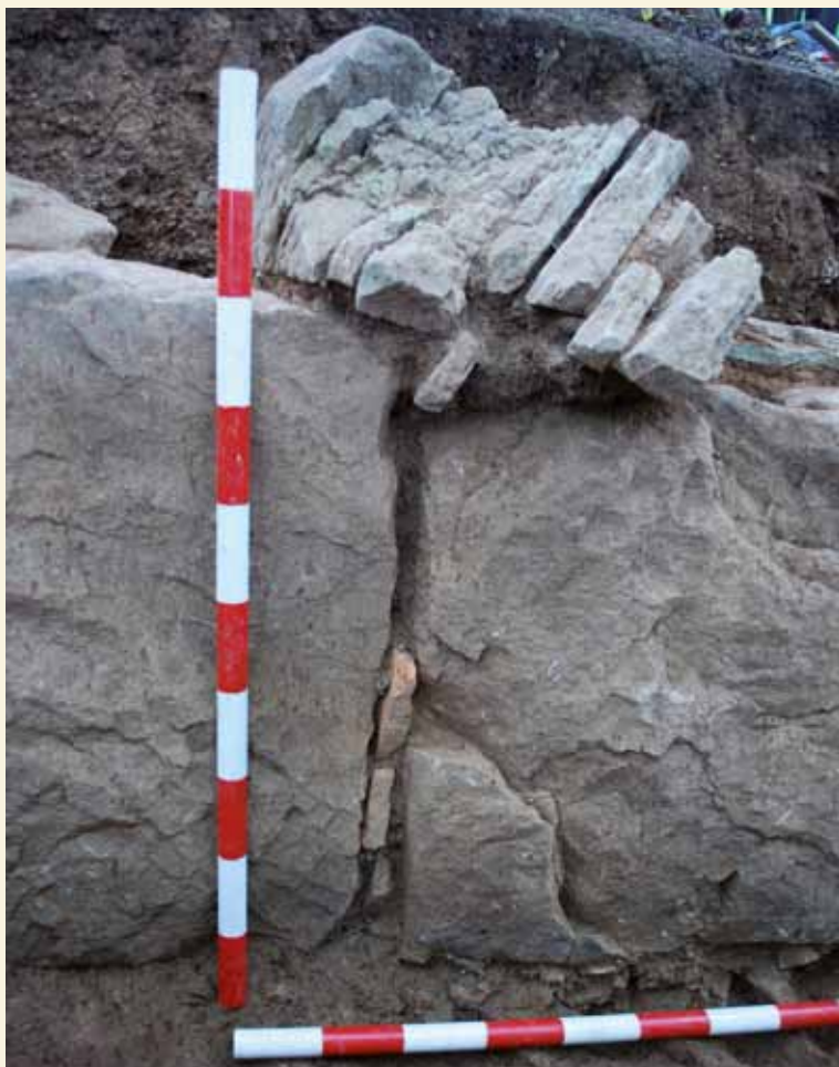
3 Profil der Mauerfront mit drei römischen Ziegelfragmenten in einer Fuge, Foto: T. Lang, 2015
