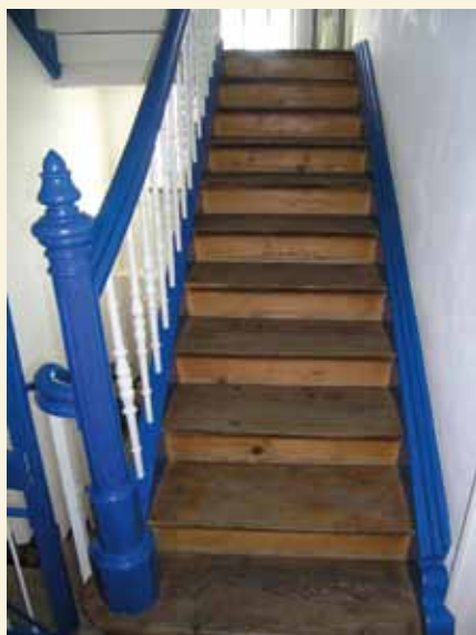
21 Regionalverband Saarbrücken, Gemeinde Saarbrücken, Gemarkung Malstatt-Burbach, Von der Heydt 15, ehemalige Schule, 1874 (Einzeldenkmal im Ensemble Grubensiedlung Von der Heydt), Foto: 2015
