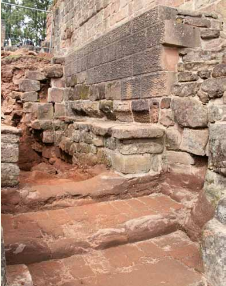
1 Blick von Süden in den Vorraum, im Hintergrund die ehemalige Heizkammer, Foto: H. Feldhaus, 2014
