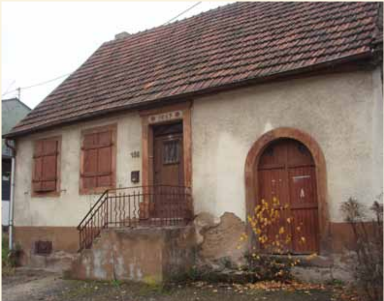
1 Völklingen-Ludweiler, Lauterbacher Straße 136, Ansicht vor Instandsetzung, Foto: 2015
