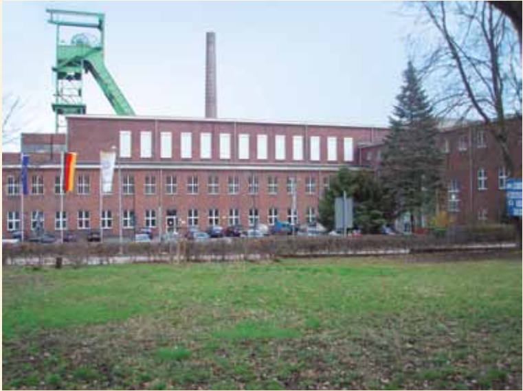
Das Landesdenkmalamt im instand gesetzten Zechegebäude des ehemaligen Bergwerks Landsweiler-Reden, Foto: 2008
