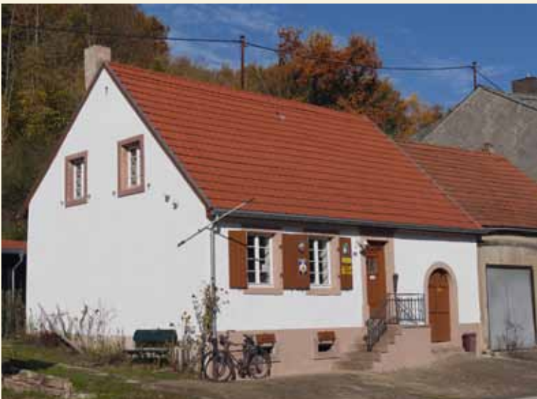
2 Völklingen-Ludweiler, Lauterbacher Straße 136, Ansicht nach Instandsetzung, Foto: 2015
