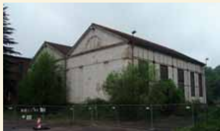
22 Regionalverband Saarbrücken, Gemeinde Saarbrücken, Gemarkung Dudweiler, Grube, Flur 23, Flurstück 36/9, Doppelfördermaschinenhaus bei Schacht II der Grube Jägersfreude, um 1925 (Löschung), Foto: 2007
