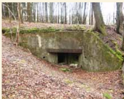
10 Landkreis St. Wendel, Gemeinde Nohfelden, Gemarkung Walhausen, Birkenfelderweg (Gewann), Flur 1, Flurstück 1, Kampfbunker WH-Nr. 1055, Luftverteidigungszone West, 1939 (Einzeldenkmal)
