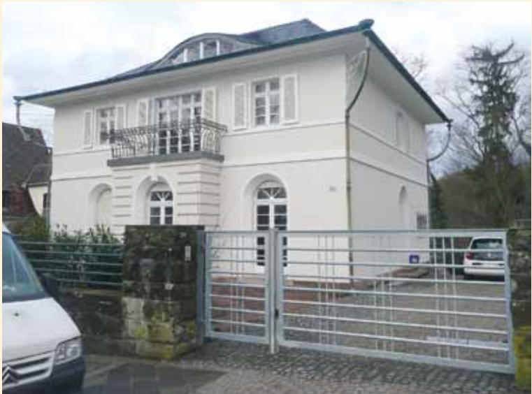
Rotenbühlerweg 39, Straßenfassade, Foto: Rost 2015
