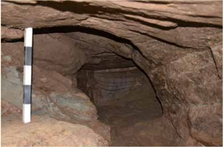
2 Wallerfangen-St. Barbara, Stollen Bruss. Blick in den Kriechgang im Abbauraum Das Profil im Hintergrund zeigt einen Haufen Versatz rechts auf der Sohle und die lehmigen Schwemmschichten, mit denen der Bereich komplett verfüllt war, Foto: G. Körlin, 2015
