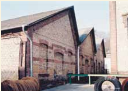
29 Saarpfalz-Kreis, Gemeinde St. Ingbert, Gemarkung St. Ingbert, Alleestraße 11, Stangenzughalle, 1912 (Löschung), Foto: Archiv LDA
