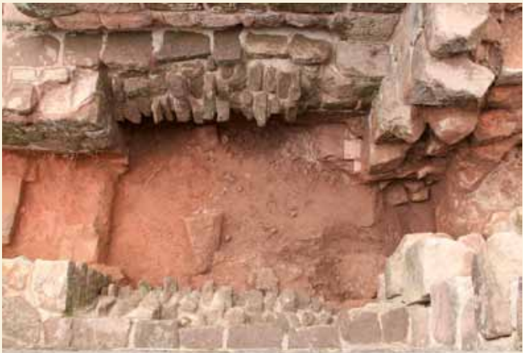
3 Aufsicht in die Heizkammer mit Gewölberekonstruktionen, links abgemauertes Schürloch, rechts Rauchabzug mit nachträglich eingestellter Mauer, Foto: H. Feldhaus, 2014
