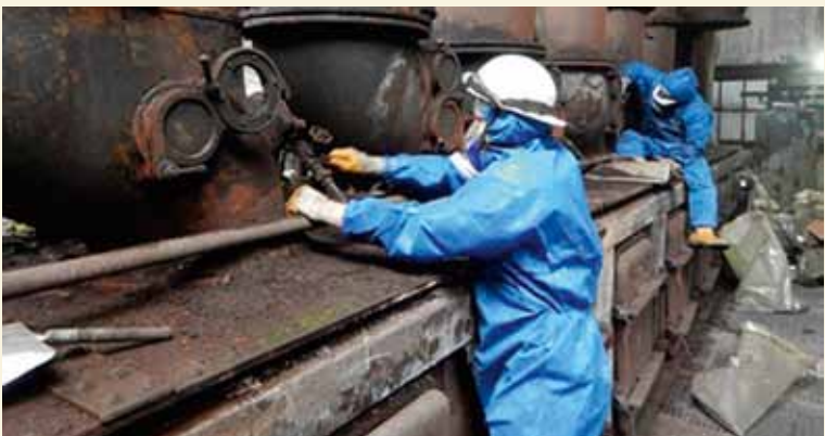
5 Schadstoffsanierung, Foto: Kluge/Lobbe AG 2015
