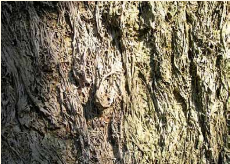
4 Saarbrücken Brebach, Halberg-Stellung Tarnputz des Bunkers WH-Nr. 316, Foto: 2013
