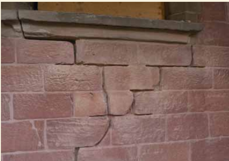
1 Schiffweiler-Heiligenwald, Karlstraße 1, Instandsetzungsarbeiten, Foto: 2015
