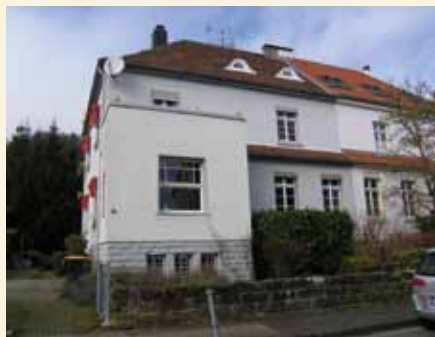
26 Regionalverband Saarbrücken, Gemeinde Saarbrücken, Gemarkung St. Arnual, Virchowstraße 30, Flur 21, Flurstück 105/6, Doppelwohnhäushälfte, 1922, Architekt Josef Müller, (Einzeldenkmal), Foto: 2014
