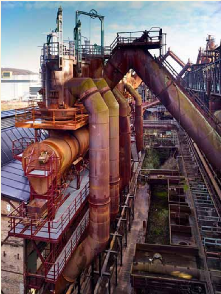
10 Außenbau TGR II nach Abschluss der Sanierung, Foto: Tom Gundelwein 2016
