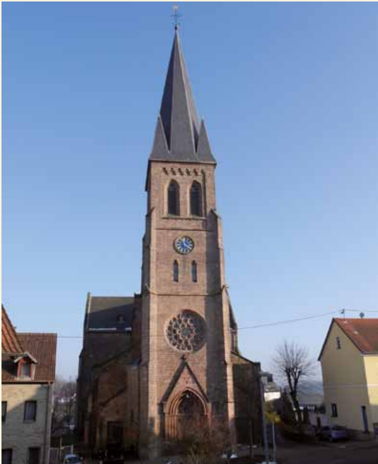
1 Landsweiler-Reden, Kath. Pfarrkirche Herz-Jesu, Ansicht, Foto: 2015
