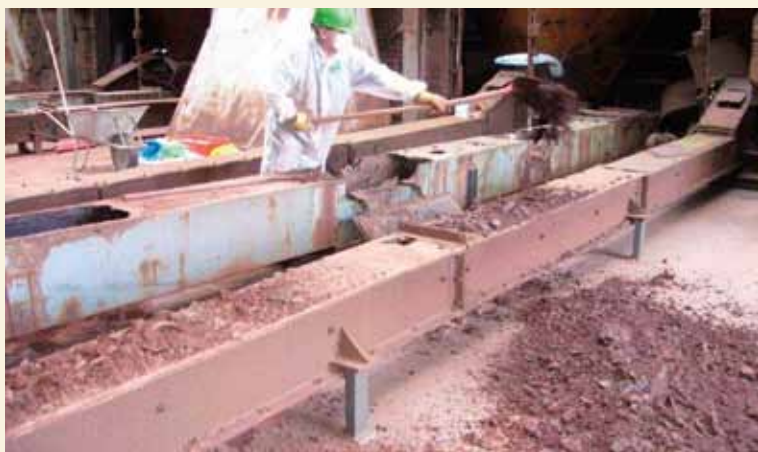
3 Sanierungsarbeiten auf der Redlerbühne, Foto: Cornelius Götz
