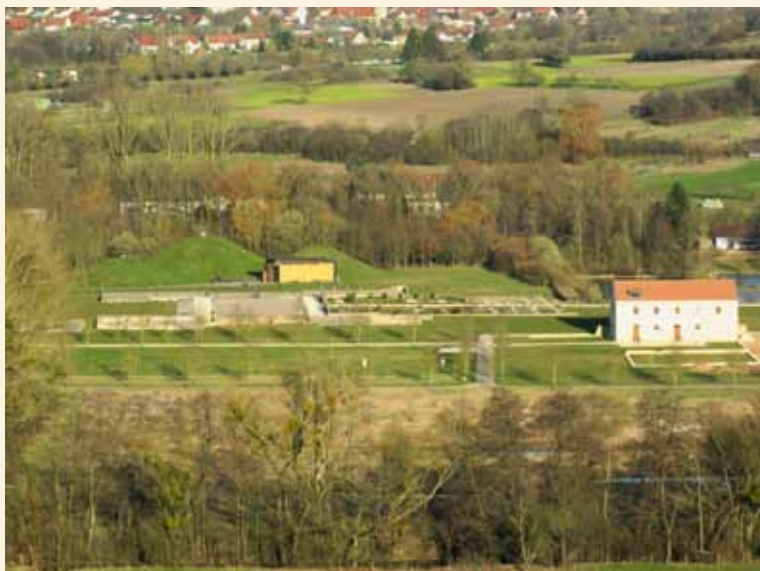
3 Reinheim. Nun deutlich im Gelände wahrnehmbar: Blick auf das Hauptgebäude der römischen Villa aus westlicher Richtung vom Willersberg. Foto: Europäischer Kulturpark Bliesbruck-Reinheim, 2015
