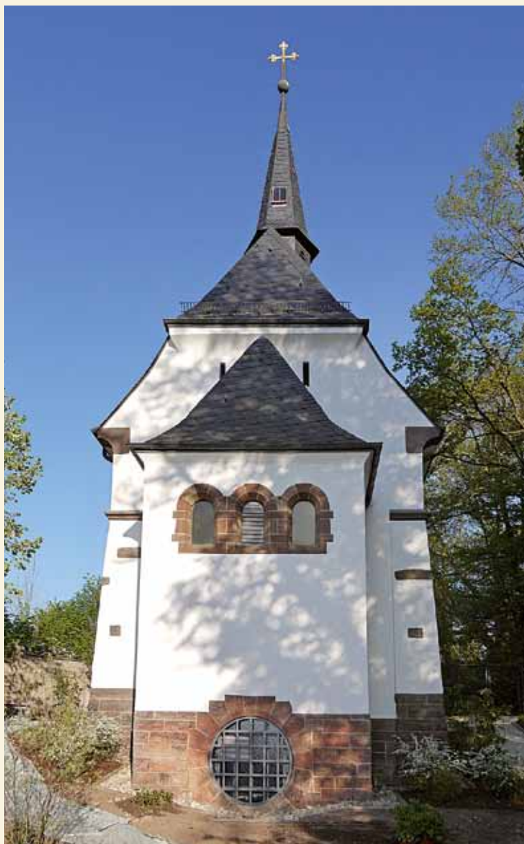
1 Röchlingkapelle, Straßenfassade, Foto: Architekturbüro Fery-Hollenbach 2014
