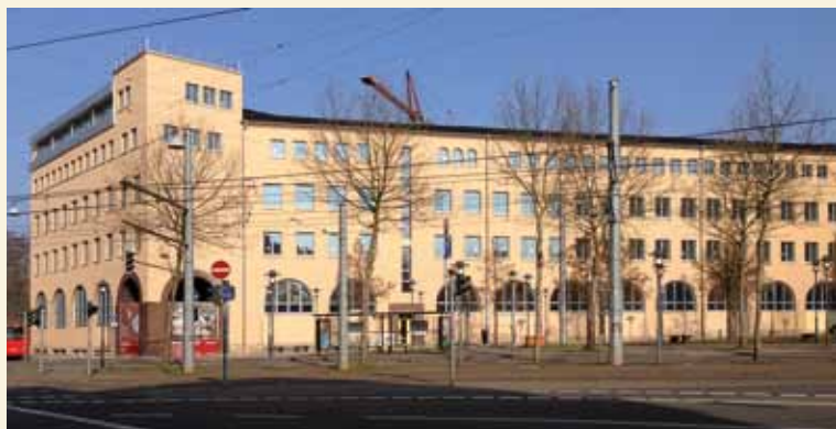
3 Hauptpost nach der Instandsetzung, Foto: Kleineher, 2014
