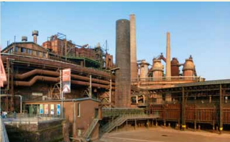
1 Gesamtansicht Sinteranlage von Außen, Foto: Wikipedia
