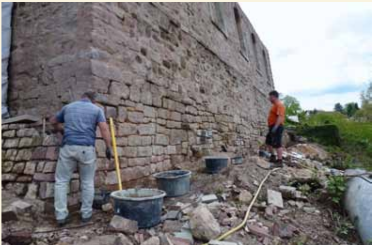
2 Schlossmauer Blieskastel, Ostseite, Mittelrisalit von Südosten, Fugarbeiten, Foto: Pressbau Erfurt GmbH, 2012
