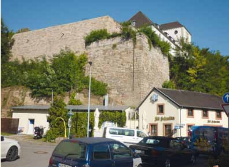
5 Schlossmauer Blieskastel, Südseite, Ansicht von Südosten, Endzustand, Foto: Reinhard Schneider, 2015
