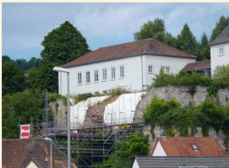
4 Schlossmauer Blieskastel, Südseite, Ansicht von Südosten, Zustand vor Baubeginn, Foto: Pressbau Erfurt GmbH, 2013
