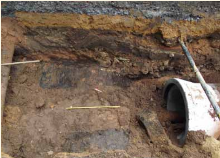
1 Wallerfangen, Hauptstraße. Deutlich sind die beiden Streifen der Verfärbung 1 auf der Sohle der Baugrube zu erkennen. Dazwischen zeichnet sich die Baugrube des alten Kanals ab, das Kanalrohr liegt tiefer. Rechts im Bild, unterhalb des gelben Rohrs (Gasleitung) wurde eine größere Menge von Keramik gefunden; die Entnahme ist an der Einbuchtung der Baugrubenwand zu erkennen. Unterhalb der Verfärbung 1 folgt ein feiner rotbrauner Sand. Länge des Zollstocks 1 Meter, Foto: K. Milkovic, 2013
