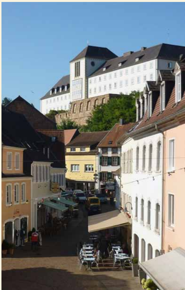
1 Schlossmauer Blieskastel, Ostseite, Ansicht von Nordosten, Endzustand, Foto: Reinhard Schneider, 2015
