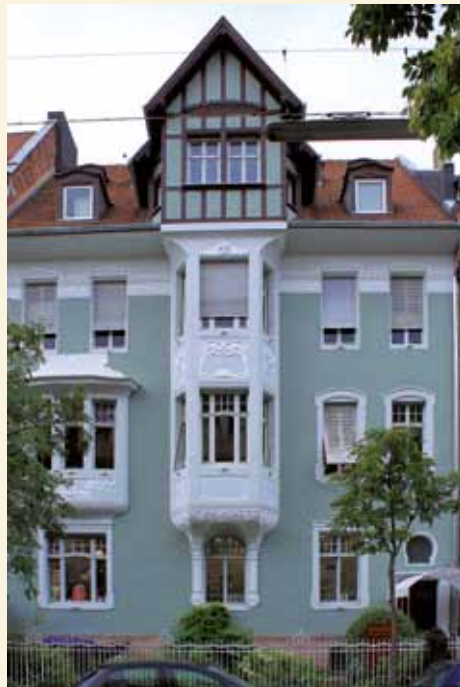
Uhlandstr. 9, Gesamtansicht nach Sanierung, Foto: Haan 2013
