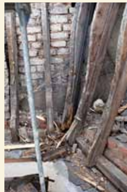
Wemmetsweiler, Rathausstraße 1, untere Mansarde Kontursparren und Fußpfette, Foto: Architekturbüro Klein, 2011
