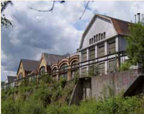
Gasmaschinenzentrale Heinitz, Foto: 2006
