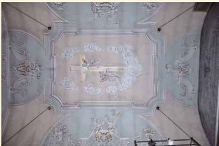
Stuckdecke, Vorzustand, Foto: K. Keller, 2012
