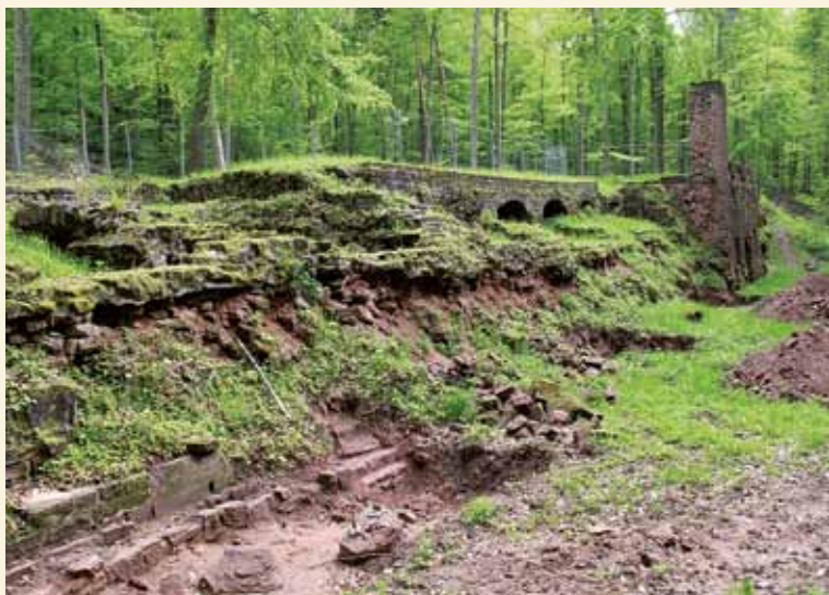
Ruine der Orangerie, Vorzustand und archäologische Sondagen, Foto: H. Feldhaus, 2013
