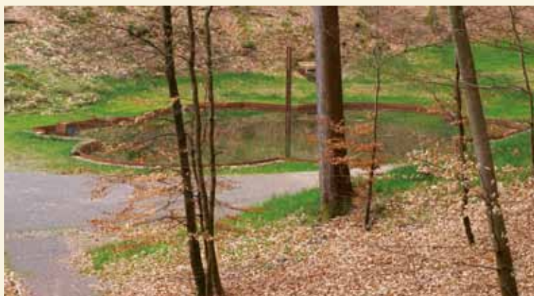
Tosbecken, Endzustand, Gesamtansicht von Norden, im Hintergrund die Einfassung der Schwanenweiherquelle, deren Wasser dem Tosbecken unterirdisch zugeführt wird, Foto: 2014
