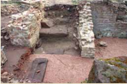
Tholey-Wareswald, während der Mauersanierung freigelegte Treppe zum Keller D 3, Foto: Römischer vicus Wareswald, 2013
