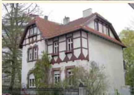
Regionalverband Saarbrücken, Gemeinde Saarbrücken, Gemarkung St. Annual, Stockenbruch 8, Flur 6, Flurstück 144/22, Wohnhaus, 1906 von Christian Towae (Einzeldenkmal), Foto: 2013
