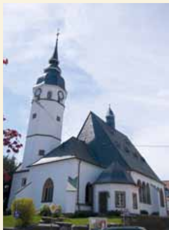
Heusweiler, Saarbrücker Straße, Ansicht, Foto: 2013
