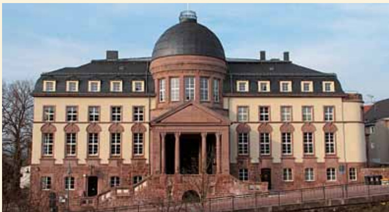
Wemmetsweiler, Rathausstraße 1, Südfassade nach Abschluss der Renovierungs- und Instandsetzungsarbeiten, Foto: Architekturbüro Klein, 2013
