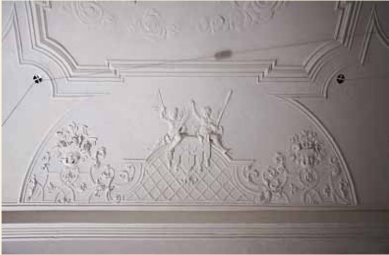
Stuckdecke Südseite, Endzustand, Foto: K. Keller, 2013
