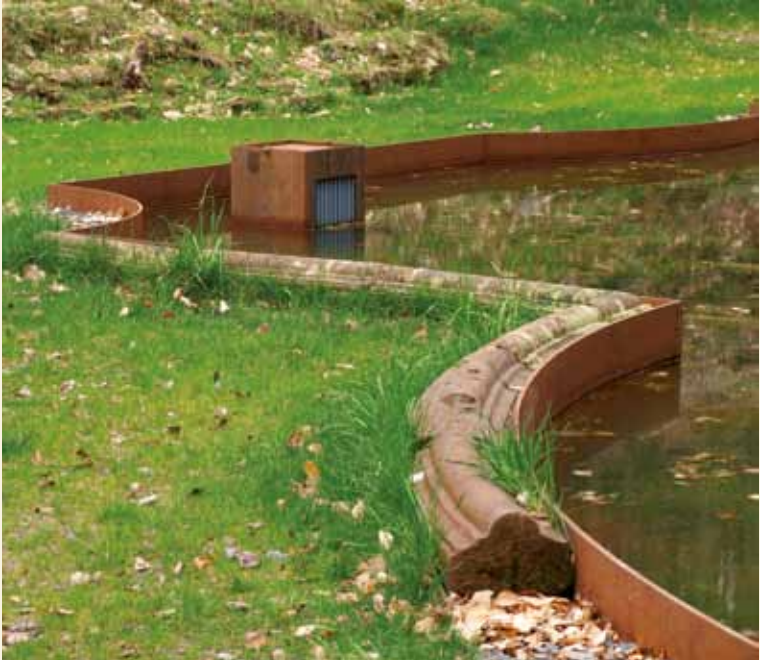
Tosbecken, Endzustand, Ausschnitt mit Mönch zur Regulierung des Ablaufs in die unteren Schwanenweiher und lose beigelegten Abdecksteine der barocken Beckeneinfassung, Foto: 2014
