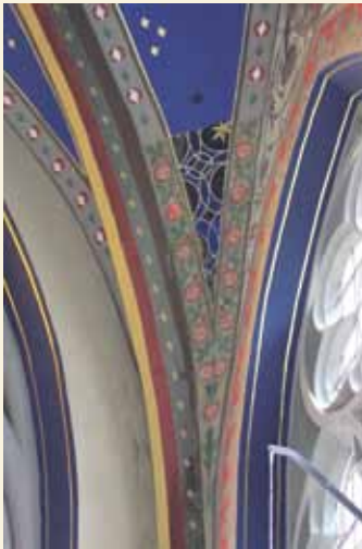
Mettlach, Kapelle St. Josef, Fassung im Gewölbe, Foto: 2013
