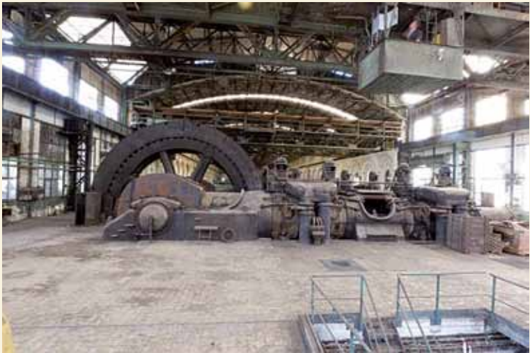
Großgasmaschine Differdange (L), Foto: 2012
