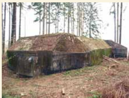
Regionalverband Saarbrücken, Gemeinde Saarbrücken, Gemar- kung Dudweiler, Im Lerchenfeld, Flur 24, Flurstück 1/4 Artilleriebatterie Im Lerchenfeld - vier Geschützschartenstände, WH-Nr. 7459a, 1939 - Batterieführungsstand, WH-Nr. 7459b, 1939 (Ensemble), Foto: 2013
