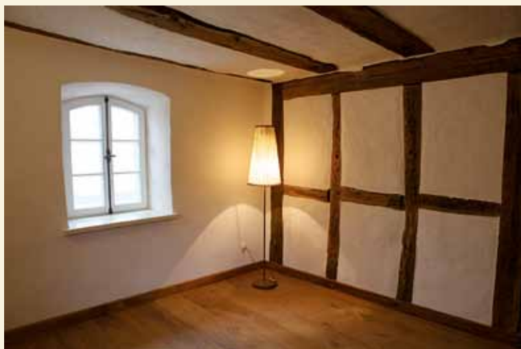
Wustweiler, Zum Stockkenborn 2, Fachwerkwand und Lehmwickeldecke, Foto: 2013
