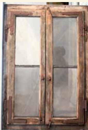
Zweiflügeliges Fenster mit Bleisprosse, um 1800, Foto: 2012
