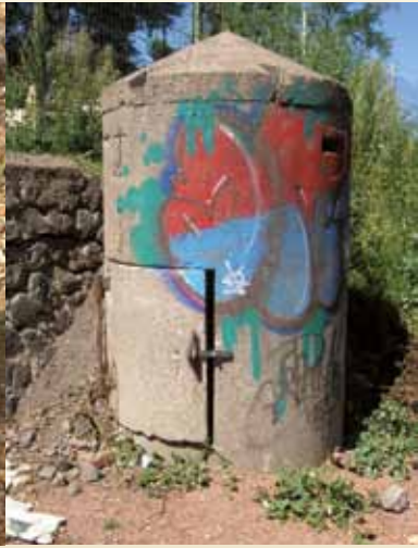
Regionalverband Saarbrücken, Gemeinde Saarbrücken, Gemarkung Malstatt-Burbach, Käthe-Kollwitz-Straße, Flur 8, Flurstück 86/281, Splitterschutzzelle, zwischen 1942-1945 (Einzeldenkmal)
