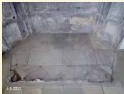
Befund des bauzeitlichen Bodenbelags nach Abbau des nördlichen Grafenstuhls, Foto: Kraemer Partner Architekten, 2011
