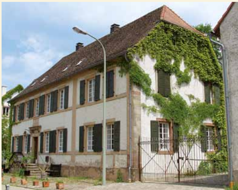
Blieskastel-Mimbach, Wohnhaus Mühlgasse 30, Foto: 2004
