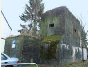
Landkreis Merzig-Wadern, Gemeinde Merzig, Gemarkung Merzig, Zur Stadthalle, Flur 21, Flurstücke 2/2, 2/3, Bunker, WH-Nr. 350, Westbefestigung, 1938 (Einzeldenkmal)
