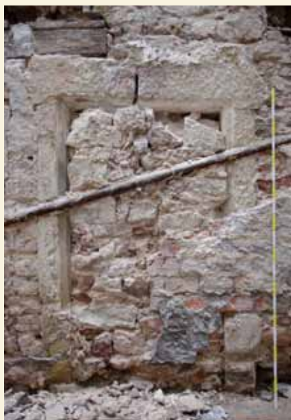
Spätgotisches Türgewände am Treppenturm bei Freilegung, Foto: Leiß, Tholey, 2012
