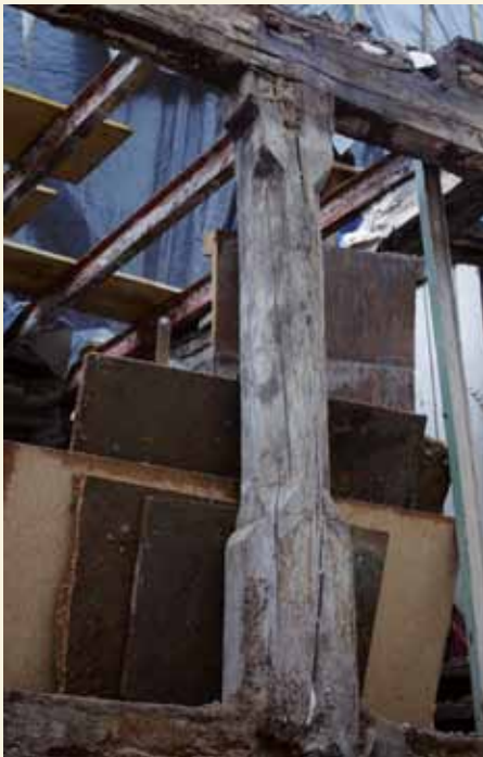
Dachstuhlsäule von 1526, Foto: Leiß, Tholey, 2012
