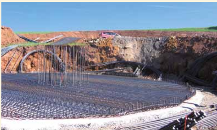
Beispiel für die Baugrube einer Windkraftanlage, hier auf dem Friedenberg bei Hirstein, Foto: 2012
