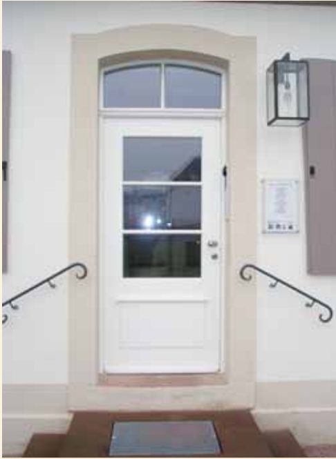
Püttlingen, Rathausplatz 3, Haupteingang wie vor 1938, Foto: 2012
