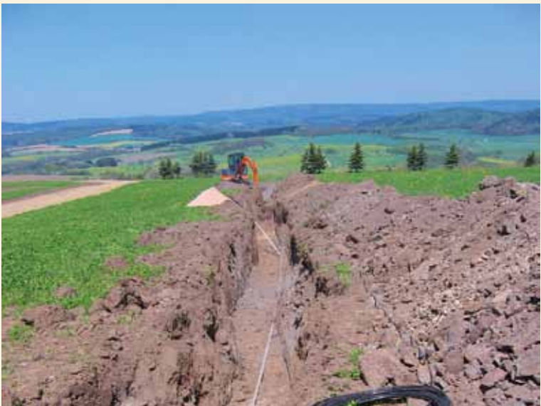
Beispiel für die Kabelgräben zur Vernetzung der Windkraftanlagen, hier auf dem Friedenberg bei Hirstein, Foto: 2012
