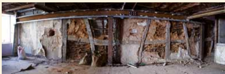
Fachwerkwand von 1715/16 – 1. Obergeschoss, Foto: Leiß, Tholey, 2012
