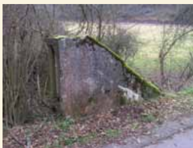
Landkreis St. Wendel, Gemeinde Obertal, Gemarkung Steinberg-Deckenhardt, In der untersten Mehbach (Gewann), Flur 11, Flurstück 68, Durchfahrtsperre, Westbefestigung, 1939 (Einzeldenkmal)
