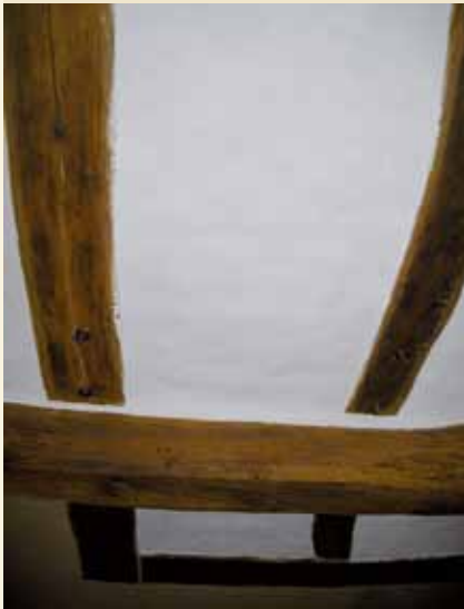
Wustweiler, Zum Stockelborn 2, sanierte Lehmwickeldecke, Foto 2013
