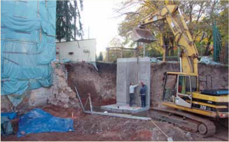
Wallerfangen, Villeroystr. 1a. Die NW-Ecke der Baugrube, die in den ehemaligen Friedhof der mittelalterlichen Stadt einschneidet, wird mit Betonwinkeln gesichert. Dahinter ist links noch die große, grau verfüllte Grube zu erkennen, die auf den systematischen Abbruch der gotischen Kirche 1688 zurückgeht, Foto: 2012
