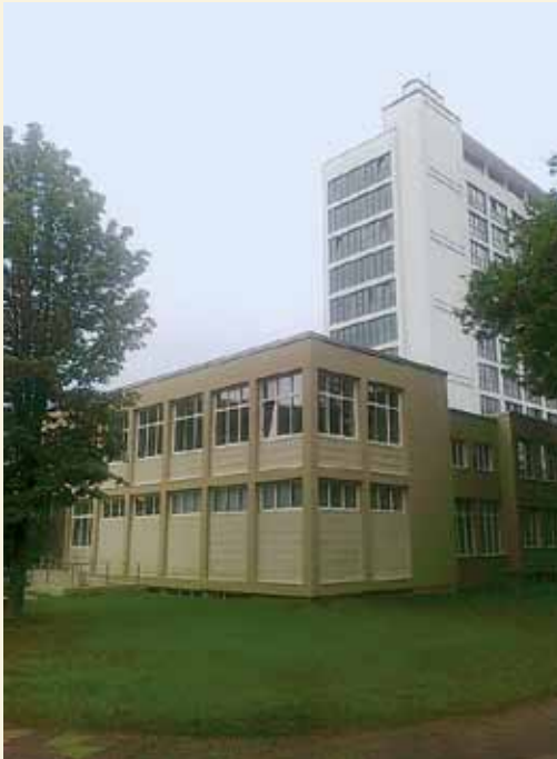
Teilansicht Bibliothek Außenbau – Nach Fertigstellung, Foto: 2012
