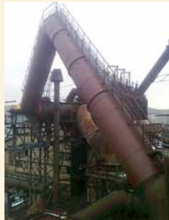
Saniertes Hosenrohr nach Einbau, Foto: 2011
