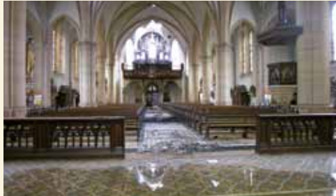
Innenansicht nach dem Brand des Dachstuhls 2007. Foto: R. Willenborg 2007
