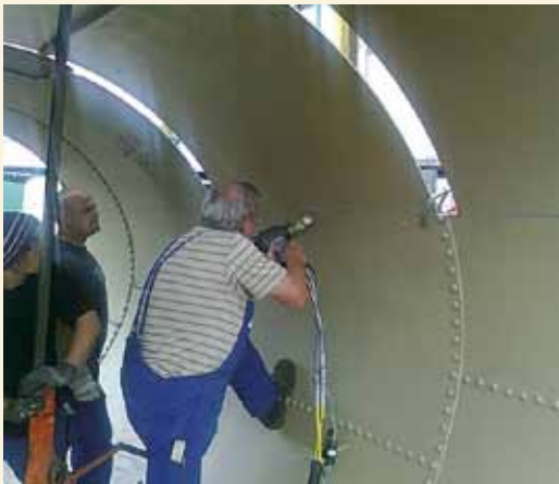
Einbau von Reparaturblechen mit Niettechnik, Foto: 2011
