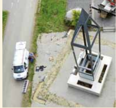
Wareswald: Bauarbeiten am Pfeilergrabmal, Foto: 2011
