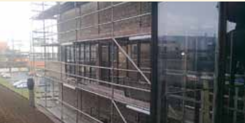
Betoninstandsetzung an der Gebläsehalle, Foto: 2011
