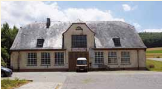
Lebach-Jabach, Dillinger Straße , Flur 3, Flurstück 1/218, Werkstattgebäude, Foto: 2011
