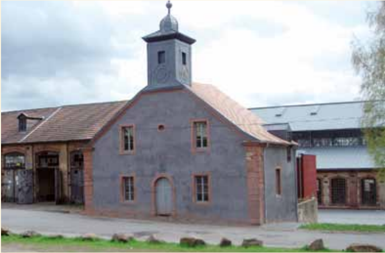
St. Ingbert, Alte Schmelz, Möllerhalle, Ansicht von Nordwesten, Endzustand, Foto: 2012
