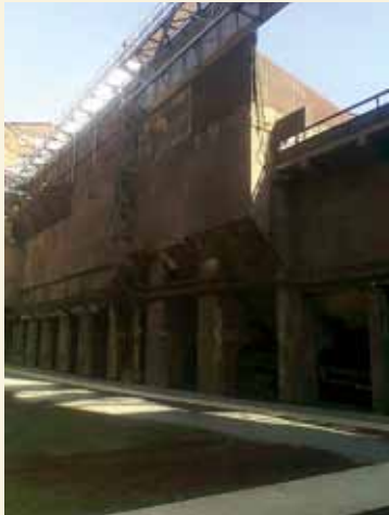
Rohstoffbunker nach erfolgter Betoninstandsetzung, Foto: 2011
