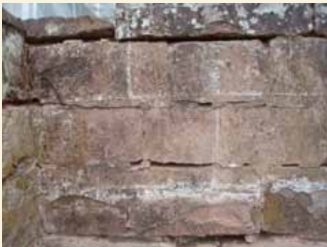
Klosterruine Wörschweiler, Kapitelsaal Nordwestecke, Befund Putzmörtel mit aufgemalten Quaderfugen, Foto: 2011
