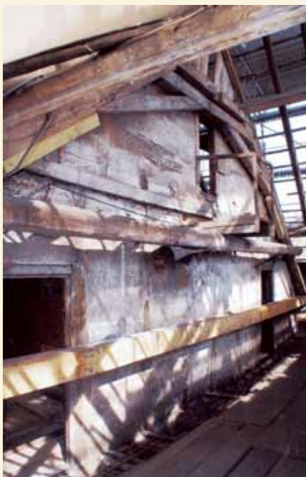
St. Ingbert, Alte Schmelz, Möllerhalle, bauzeitliches Bindergespärre mit erneuertem Zugbalken, Foto: N. Leiß 2010
