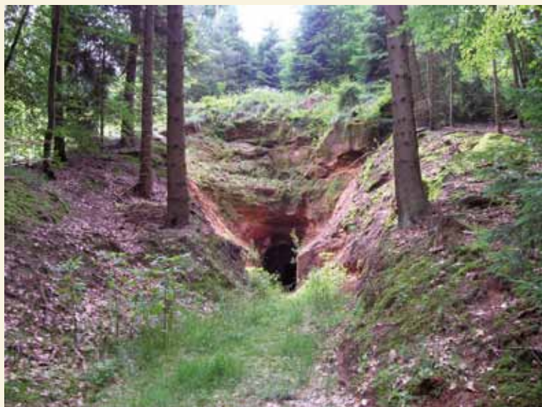
Saarpfalz-Kreis, Gemeinde Kirkel, Gemarkung Kirkel- Neuhäusel, Schulzenhang (Gewann), Flur 5, Flurstück 1141, minierte Stollenanlage WH-Nr. 9162a, 1938-1939 (Einzeldenkmal)
