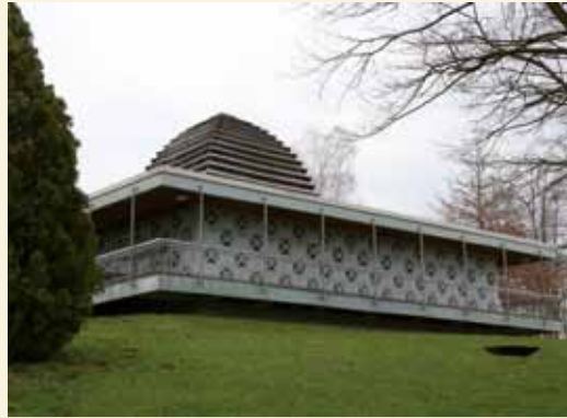
Dillingen-Diefflen, Friedhof, Einsegnungshalle von Osten, Foto: 2011
