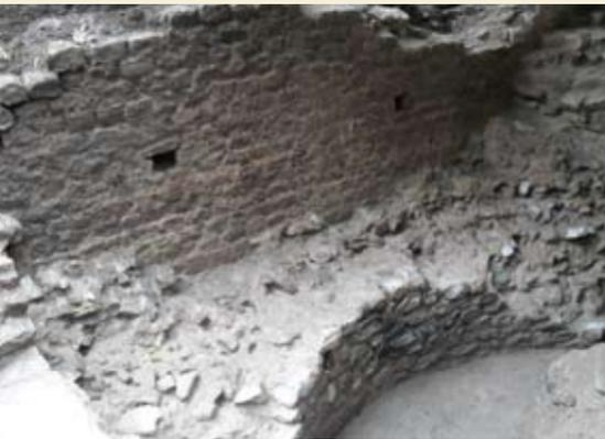
Tohley, Schaumberg, Römischer Großbau in Kleinquadermauerwerk mit Kelleranbau und Verstärkung durch Bogenmauer (Joachim Zeune, Büro für Burgenforschung, Eisenberg-Zell, 2010)
