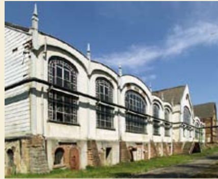
Gasmaschinenzentrale Heinitz, Foto: 2009
