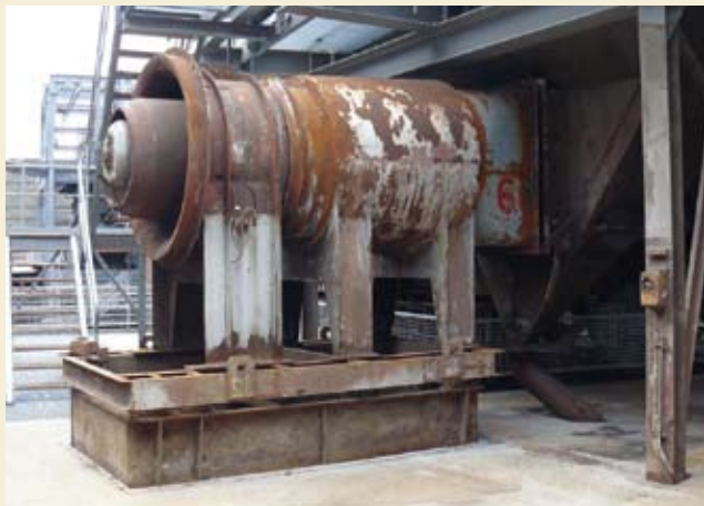
Völklingen: Lüfter am Sinterkühler, Foto: Claudia Reck
