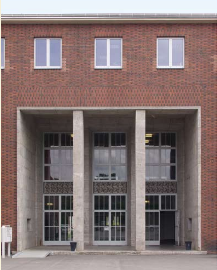
Das Landesdenkmalamt im instand gesetzten Zechengebäude des ehemaligen Bergwerks Landsweiler-Reden. Foto: 2008
