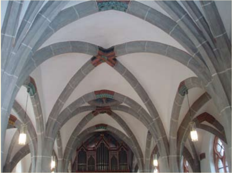
Gewölbe und Rippen nach Abschluss der Sanierung, Foto: 2009
