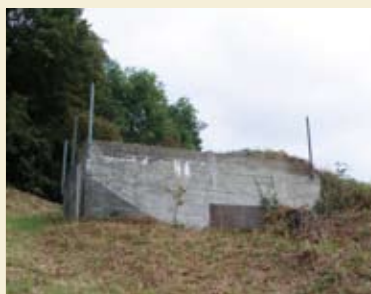
Landkreis Merzig, Gemeinde Merzig, Gemarkung Merzig, Bornewasserweg, Flur 6, Flurstück 503/206, Westwallbunker WH-Nr. 307, MG-Schartenstand, 1938 (Einzeldenkmal)
