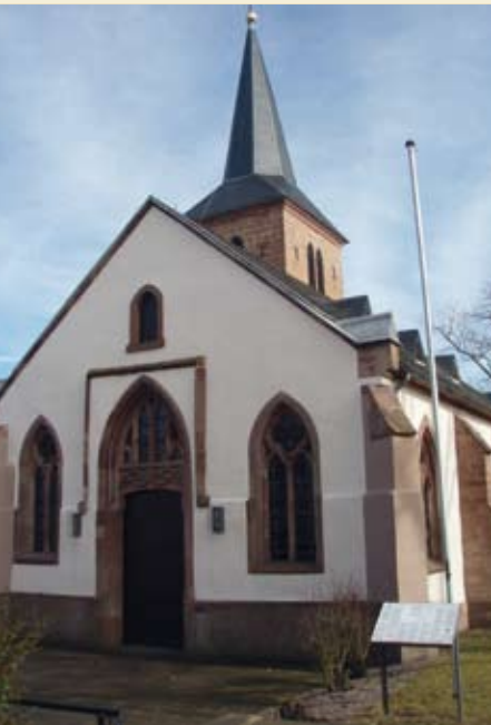
Köllerbach: Ev. Pfarrkirche nach der Sanierung. Foto: 2009
