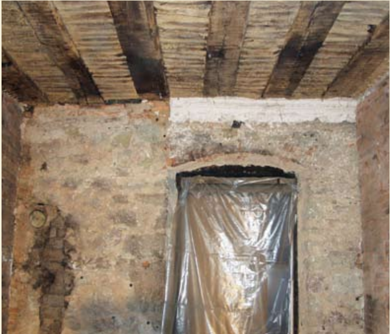
Raum 1.8: Außenwand und Holzbalkendecke mit Stuckfragment nach der brandschadensbedingten Freilegung, Foto: 2006
