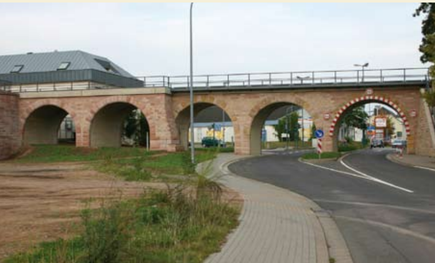
St. Ingbert: Gesamtansicht sanierte Brücke, Foto: Glöckner 2009
