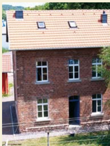
Landkreis Saarlouis, Gemeinde Dillingen, Gemarkung Pachten, Werderstraße, Flur 6, Flurstück 82/35, Dienst- und Werkstattgebäude der Eisenbahn, um 1900 (Ensemblebestandteil im Ensemble Lokschuppen)
