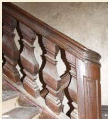
Eichenholztreppe mit Balusterbrüstung, Foto: 2006
