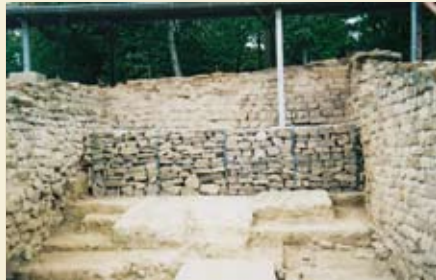
Wareswald. Bestandserhaltung: Neuverfugung der Mauersteine und vorgesetzte Gabionen bewahren die originale Bausubstanz, Foto: K.-P. Henz 2009
