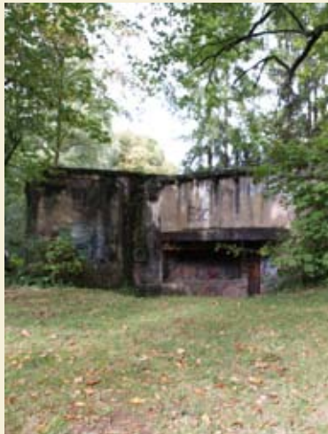
Landkreis Saarlouis, Gemeinde Ensdorf, Gemarkung Ensdorf, Prälat-Anheier-Straße, Flur 2, Flurstück 75/27, Westwallbunker WH-Nr. 666, MG-Kasematte, 1939 (Einzeldenkmal)
