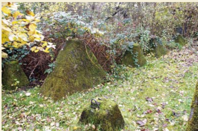
Regionalverband Saarbrücken, Gemeinde Saarbrücken, Gemarkung St. Annual Saargemünder Straße, Flur 2, Flurstück 64/5, Betonhöckerhindernis, 1939 (Einzeldenkmal)
