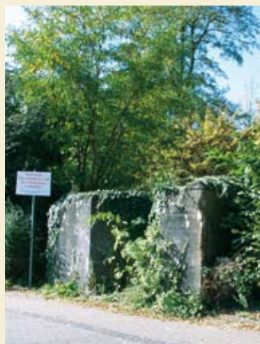
Landkreis Saarlouis, Gemeinde Dillingen, Gemarkung Dillingen, Geranienstraße, Flur 6, Flurstück 200/30, Westwallbunker WH-Nr. 31, MG-Kasematte, 1939 (Einzeldenkmal)
