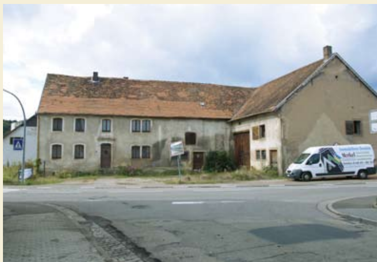
Saarpfalz-Kreis, Gemeinde Blieskastel, Gemarkung Breitung, Bliesdalheimer Straße 43, Erbhof, sog. „Haus Schetting“, 1804 und 1913 (Einzeldenkmal)
