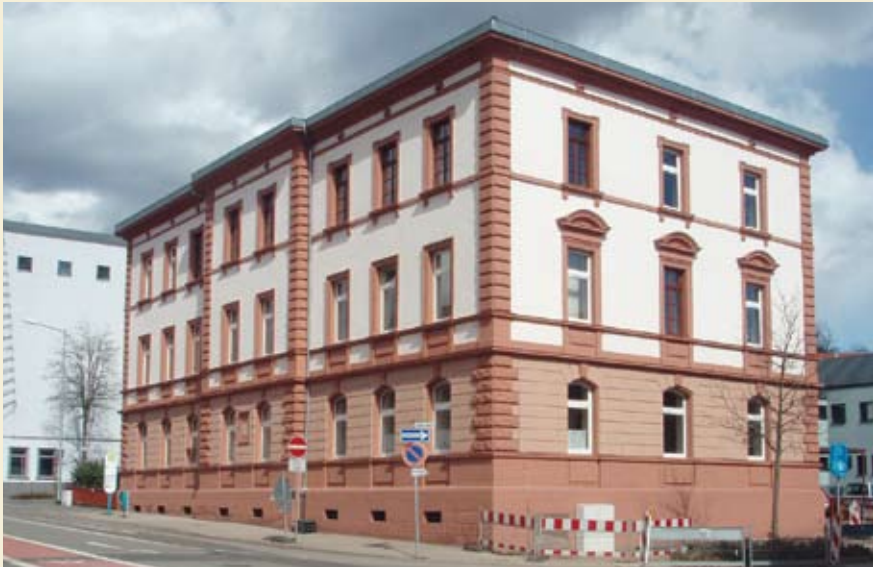
Amtsgericht Homburg: Ansicht nach Abschluss der Dach-, Putz- und Sandsteinarbeiten; Fensteraustausch begonnen, Foto: 2010
