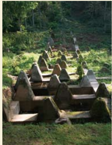
Landkreis Saarlouis, Gemeinde Nalbach, Gemarkung Piesbach, Kleppnerstraße, Flur 1, Flurstück 217, 218, 225/1, Betonhöckerhindernis, 1938 (Einzeldenkmal)
