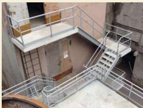
Völklingen: Geländer am elektrischen Betriebsraum, Foto: Claudia Reck
