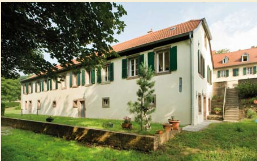
St. Ingbert: Haus Alte Schmelz 13/15, Gartenseite Endzustand, Foto: A. Klein, Saarbrücken, 2009
