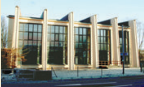
Umspannwerk Stangenmühle, Saarbrücken-Gersweiler. Architekt Peter Paul Seeberger, 1956. Foto: 2007
