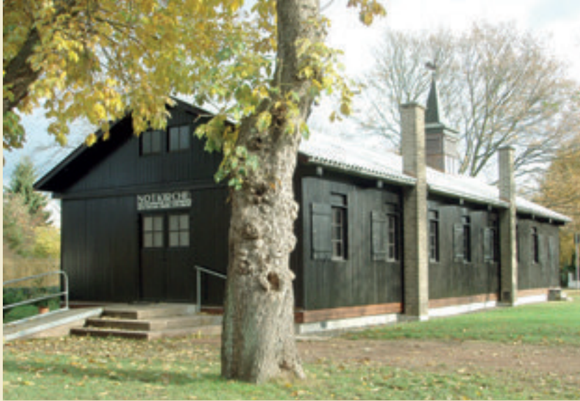
Saarbrücken, Evangelische Notkirche in Alt-Saarbrücken. Außenfassade nach der Instandsetzung. Foto: 2007
