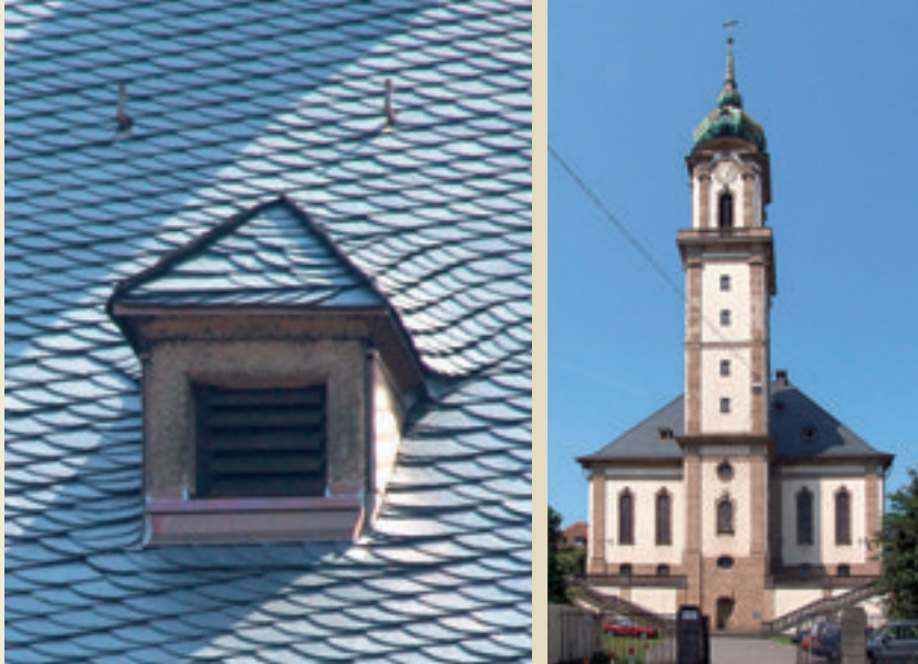
Völklingen, Versöhnungskirche mit erneuertem Schieferdach. Foto: 2007 H.-J. Stein/Kasel
