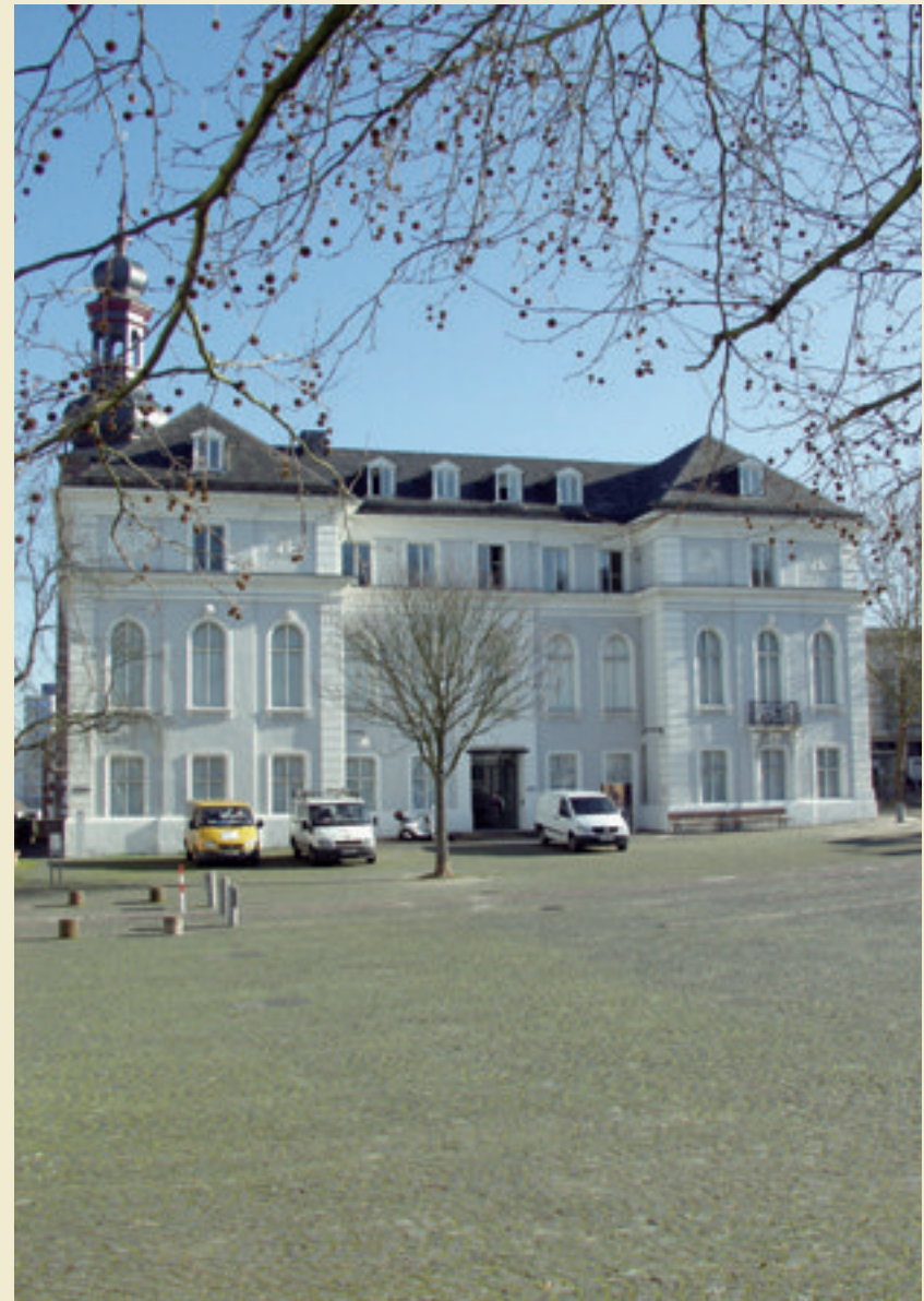
Das Landesdenkmalamt im Kreisständehaus am Schlossplatz in Saarbrücken. Foto: 2007
