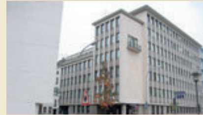
Stadtverband Saarbrücken, Saarbrücken, St. Johann, Fritz-Dobisch-Straße 12, Verwaltungsgebäude der Ruhegehalts- und Zusatzversorgungskasse des Saarlandes (RZVK), 1958-60 von Rudolf Güthler, Wandmosaik „Mensch und Arbeit“ von Fitz Zolnhofer. (Einzeldenkmal)
