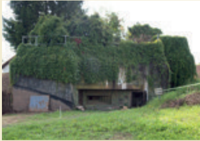
Stadtverband Saarbrücken, Heusweiler, Heusweiler, außerhalb der Ortslage WH 333, Westwallbefestigung, Mannschaftsunterstand mit angehängtem Kampfstand, 1938. (Einzeldenkmal)
