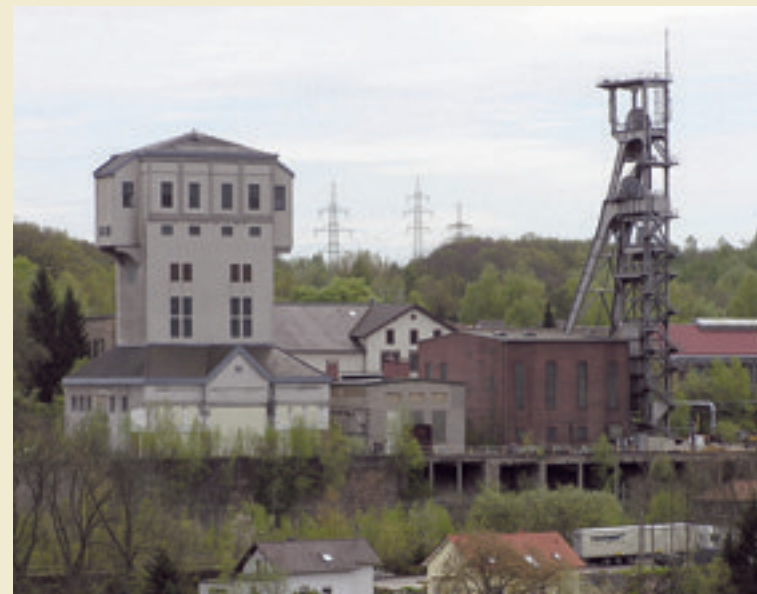
Camphausen, Fördergerüst. Zustand 2006
