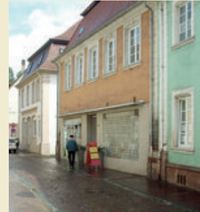
Blieskastel, Kardinal-Wendel-Straße 17, Straßenfassade nach Erneuerung der brandgeschädigten Fenster. Foto: 2007
