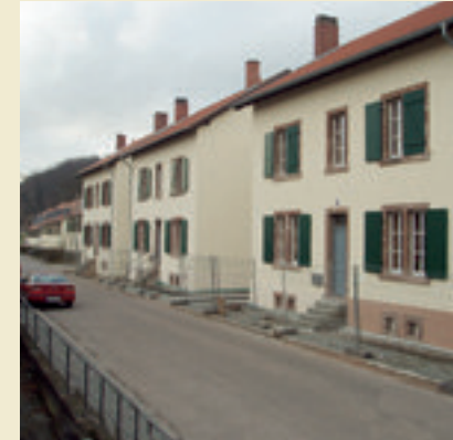
St. Ingbert, Wohnhäuser Alte Schmelz 2-8, kurz vor Abschluss der Sanierung. Foto: 2008
