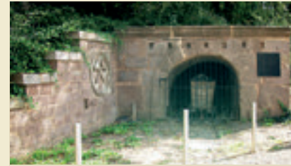
Stadtverband Saarbrücken, Heusweiler, Heusweiler, Schacht-Dilsburg, Stollenmundlöcher des Dilsburgstollens, 1844. (Einzeldenkmal)
