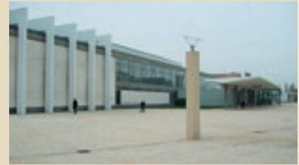
Stadtverband Saarbrücken, Saarbrücken, Hafenstraße 12, Kongresshalle mit Ausstattung, 1962-68 von Dieter Oesterlen, Metallkunst von Fritz Kühn. (Einzeldenkmal)
