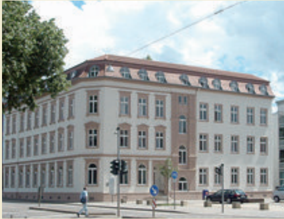
Saarbrücken, Burbach, Beamtencasino Foto: 2007
