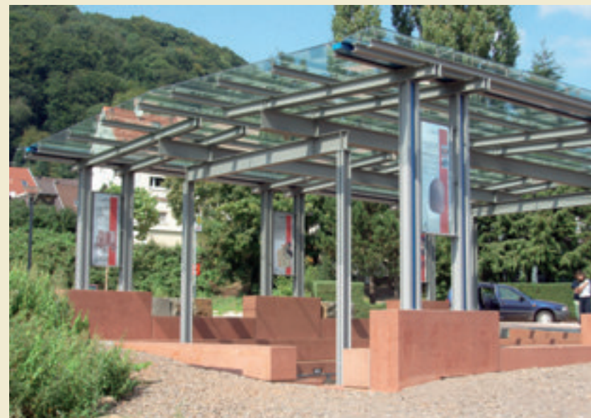
Schutzbau über einem Abschnitt der römischen Straße im Ortszentrum von Tholey. Foto: 2007
