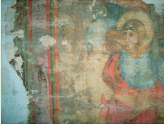
Beckingen, kath. Kirche, Kreuzstation des Pastor Leidinger von 1874/77 während der Freilegung. Foto: 2006
