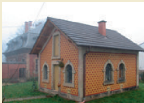
Wallerfangen, Hauptstraße 58, Villeroy'sches Rentamt, Hühnerhaus. Foto: 2007
