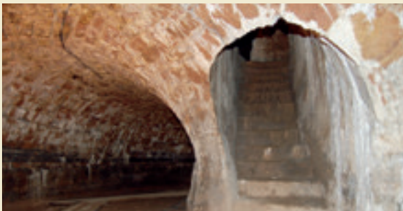
Untere Kasematte und Felstreppe der Südwestbastion. Foto: 2006
