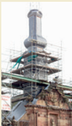
Blieskastel, Schlosskirche, großer Dachreiter nach Wiederaufsetzen des oberen Schaftes.
