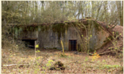
Namborn, Hofeld-Mauschbach: Doppelgruppenunterstand der Luftverteidigungszone West mit Flankierungsanlage von 1939, WH-Nr. U 38. Foto: 2006
