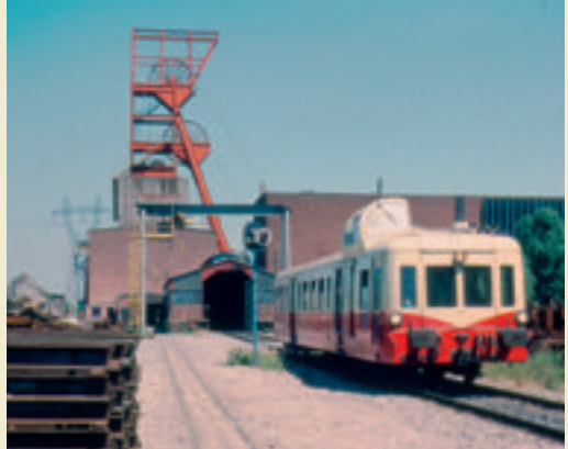
Großrosseln, Schachanlage Merlebach-Nord. Foto: 1986 Goy, Schwalbach
