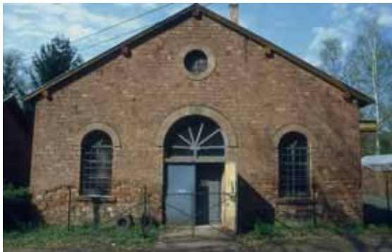
Maschinenhaus Amelung I
