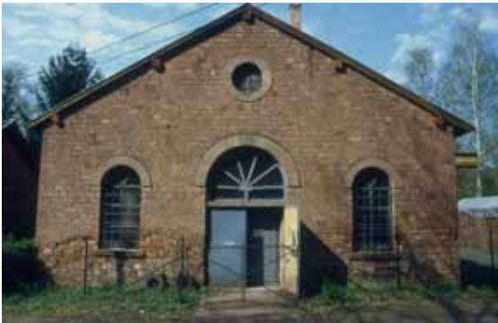
Maschinenhaus Amelung I
