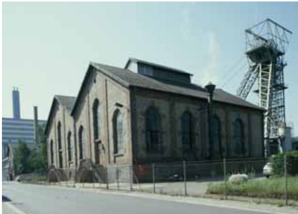
Maschinenhäuser mit Fördergerüst
