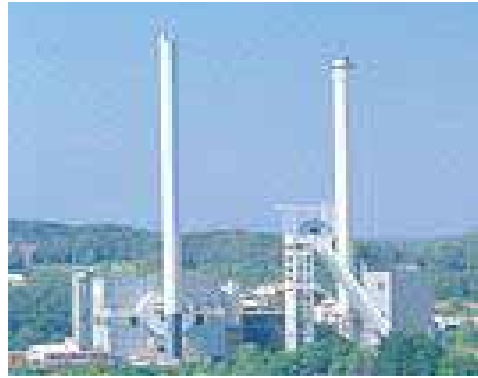
Müllverbrennungsanlage mit Fördergerüst
