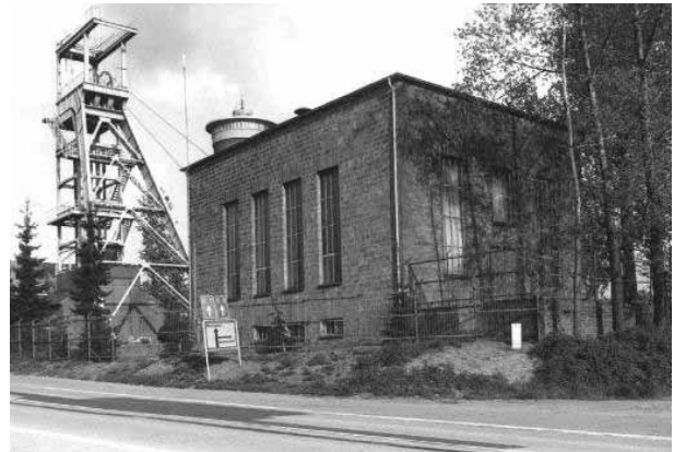
Fördergerüst mit Fördermaschinenhaus
