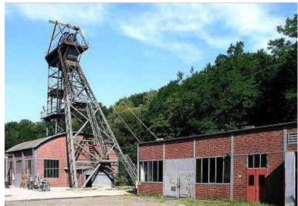
Vorderansicht mit Maschinenhaus
