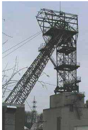
Fördergerüst Delbrück II
