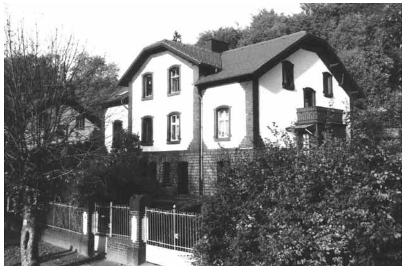
Siedlungshaus für Grubenbeamte
