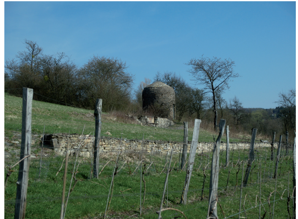
Ansicht des Weinberghäuschen westlich von Reinheim, 2009
