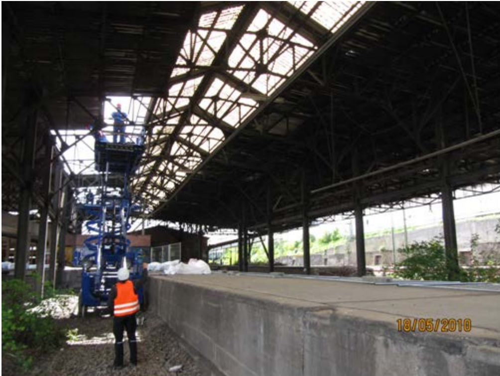
Bild 9 Abbau der Wellplatten mit Hilfe einer Arbeitsbühne
