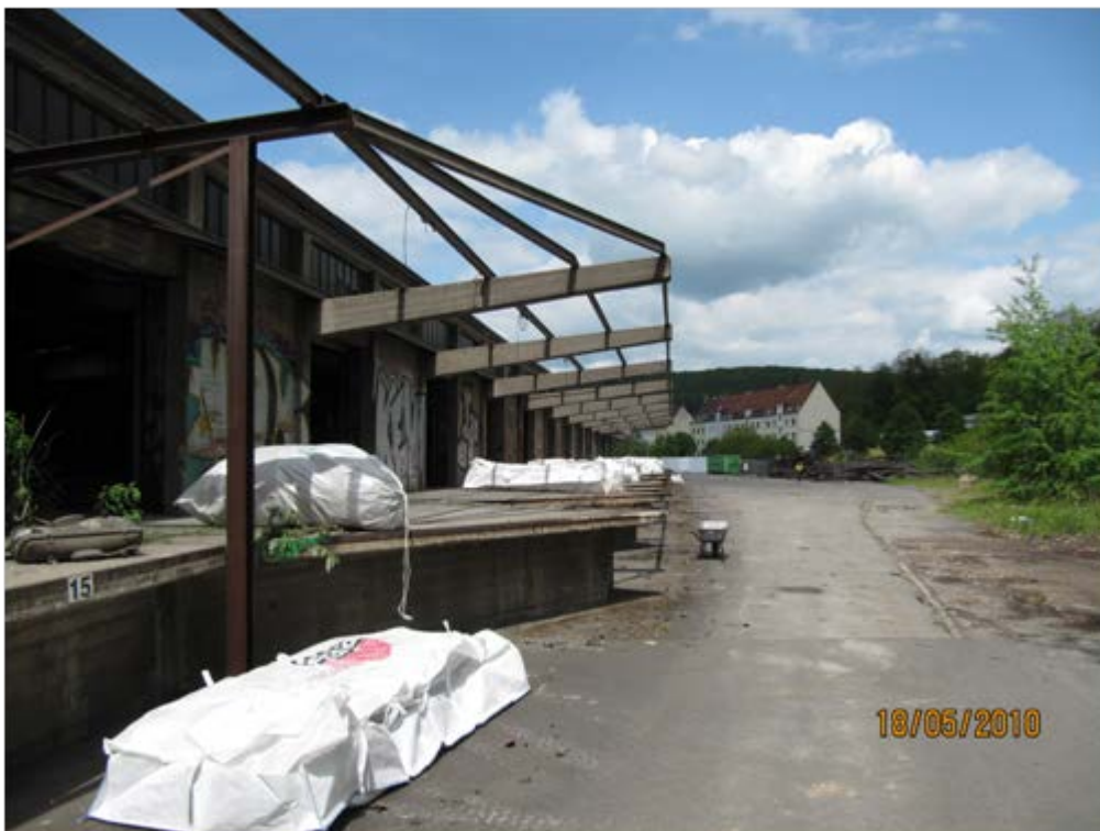
Bild 10 Transportfertig verpackte Asbestabfälle
