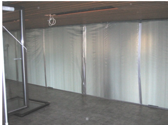
Bild 6 Abgedichtete Ständerwand
