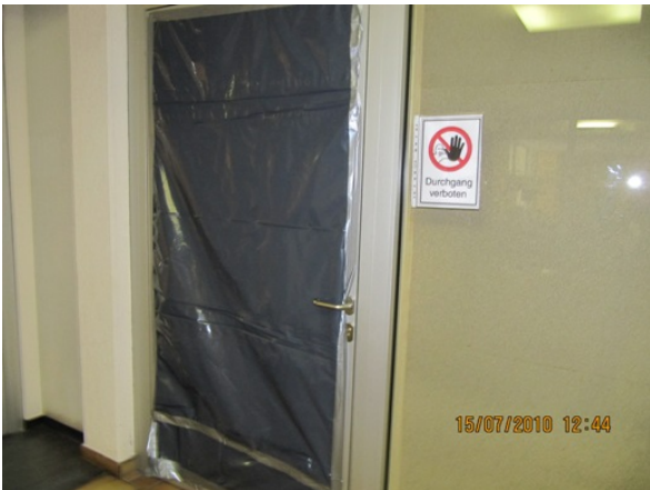
Bild 5 Räumliche Trennung des Sanierungsbereichs
