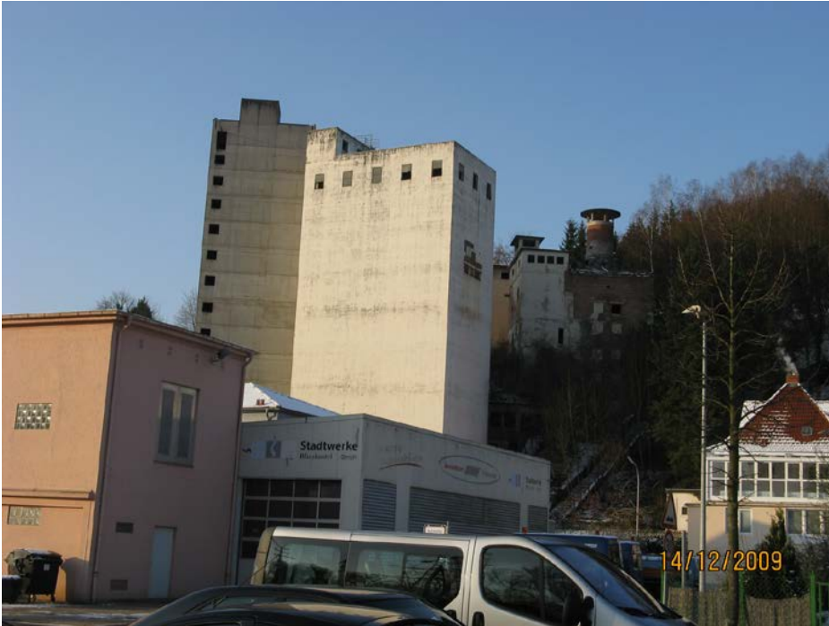
Bild 3 Die zwei zum Abriss anstehenden, betonierten Silotürme und angrenzende Gebäude
