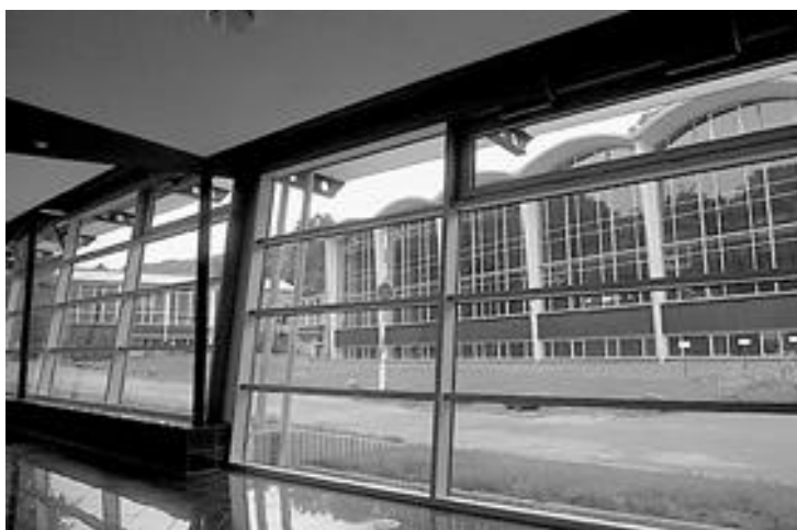
Abbildung 46: Hermann Neuberger Sportschule in Saarbrücken, Blick aus dem Foyer.
