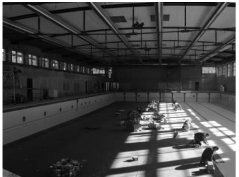
Abbildung 62: Bauarbeiten an der neuen Schwimmhalle der Hermann Neuberger Sportschule in Saarbrücken.
