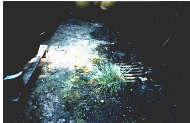
Abbildung 9 Ölverschmutzter Kanaleinlauf
