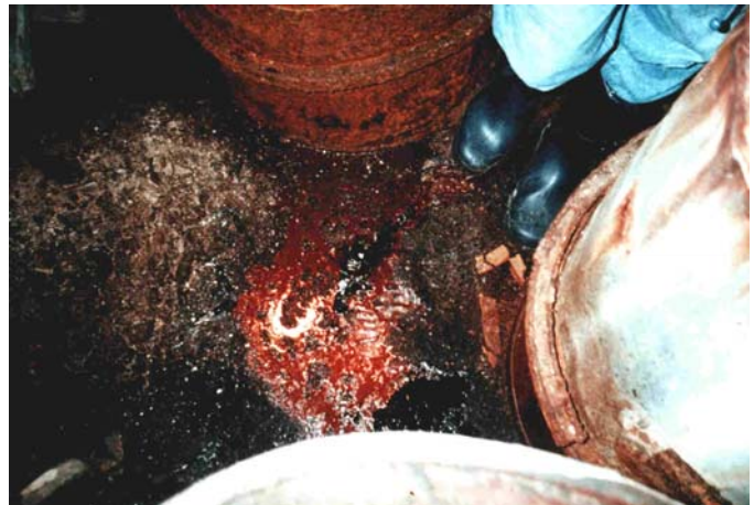
Abbildung 16 Durchrostete Fässer mit ausgelaufenem Bitumenkleber
