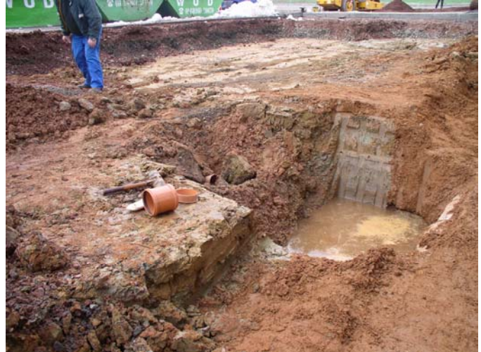
Abbildung 10 Sanierung ölkontaminierter Bodens durch Auskoffern
